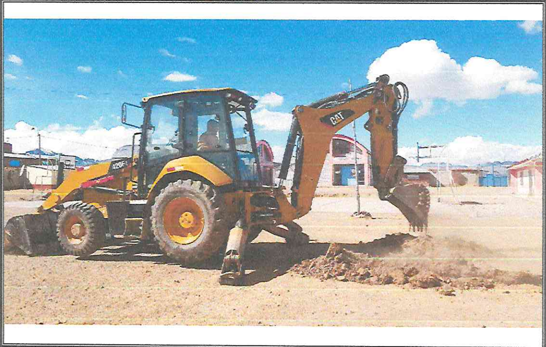
Fotografía N° 01: Vista general del TERRENO 1 al inicio de la excavación de la calicata 1, que se realizó con maquinaria - retroexcavadora.
