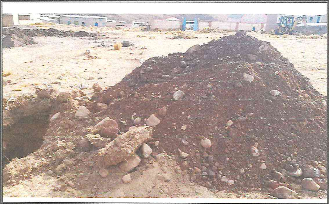
Fotografía N° 09: Vista general del TERRENO 2 durante la excavación donde se aprecia el material retirado de la excavación de la calicata 5.
