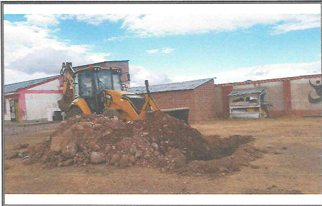
Fotografía N° 16: Se observa la clausura de excavación al término de los trabajos de campo con retroexcavadora que se está dejando el área de estudio en condiciones similares a la encontrada.
