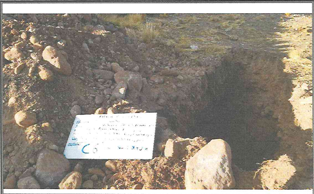
Fotografía N° 13: Vista de la CALICATA N°06 con datos del proyecto; donde se aprecia el material retirado de la exploración; con acercamiento a las paredes de la calicata, señalando parte de la estratigrafía correspondiente.
