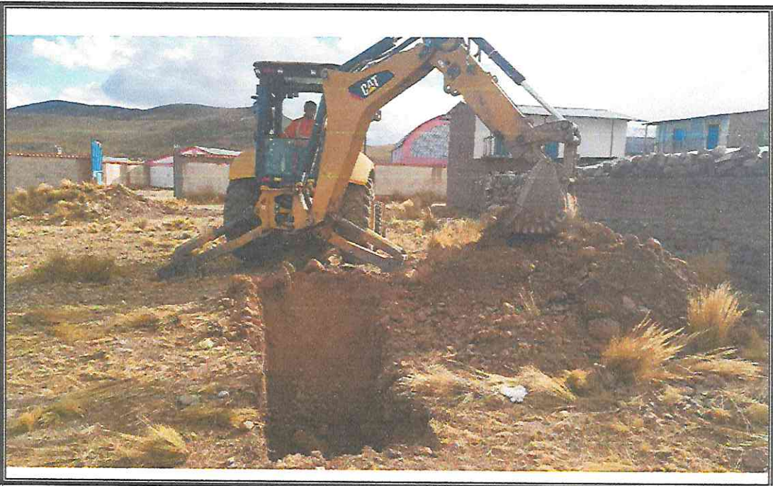
Fotografía N° 10: Vista del TERRENO 2 al inicio de la excavación de la calicata 5.
