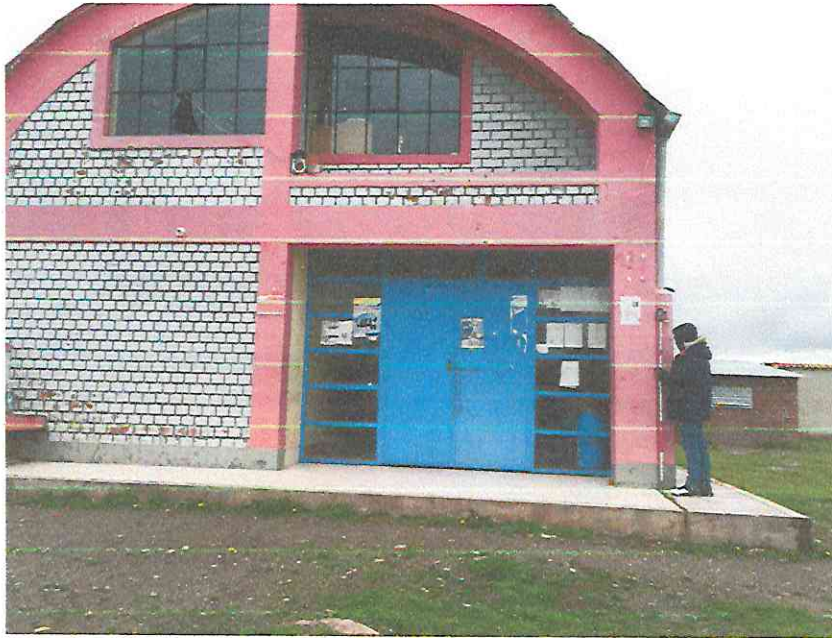
FOTO 01: Proceso de Levantamiento Topográfico T-01
