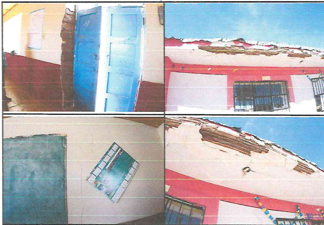
Imagen 9: Fotografías de las condiciones actuales del bloque 03.
