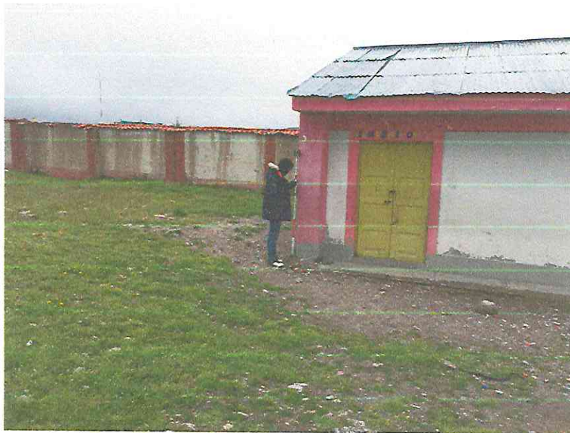
FOTO 02: Proceso de Levantamiento Topográfico T-01
