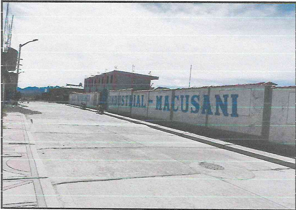
Figura 9. Puerta de Ingreso Principal a la Institución con Vía Pavimentada. Fuente. Propia
