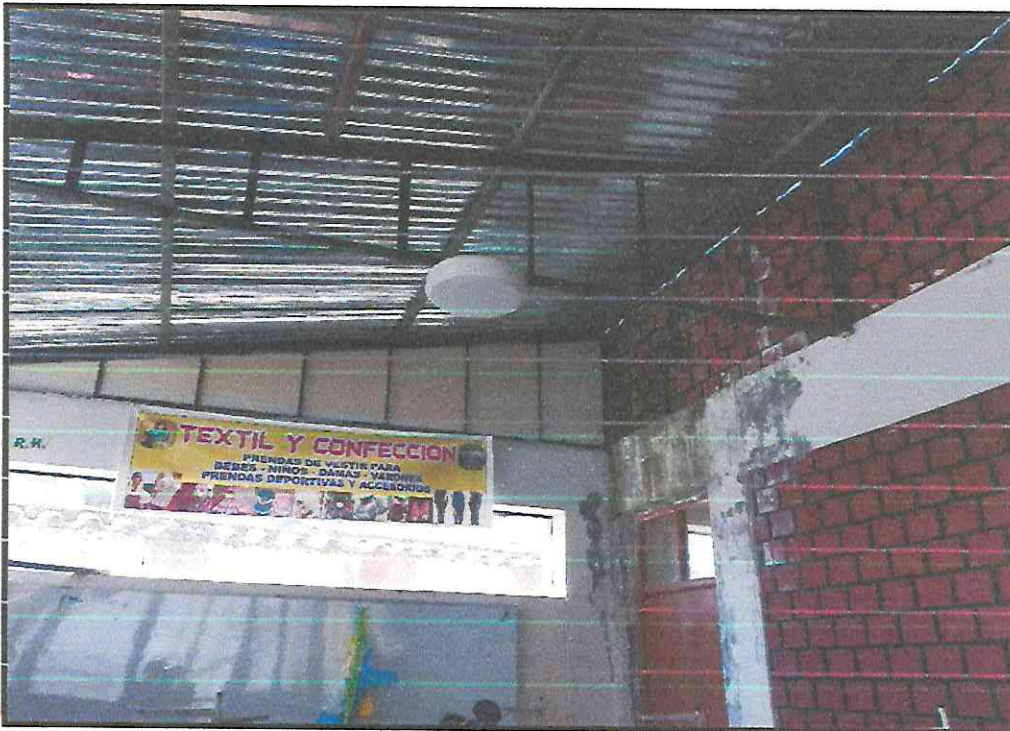
Figura 2. Vanos y Ventanas abiertas que permiten que el aire frío ingrese a los ambientes Fuente. Propia
