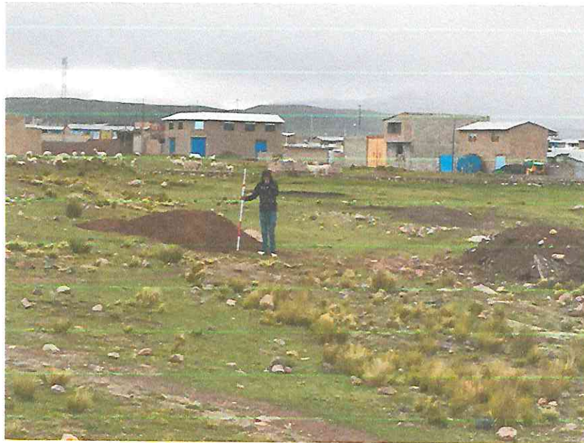
FOTO 10: Proceso de levantamiento topográfico T-02
