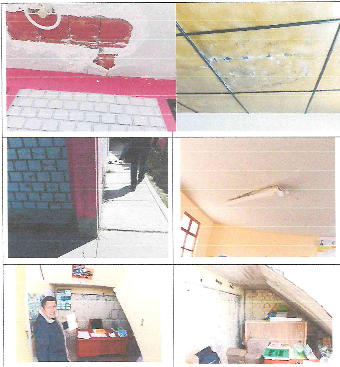
Imagen 2: Fotografías de las condiciones actuales del bloque 01.
