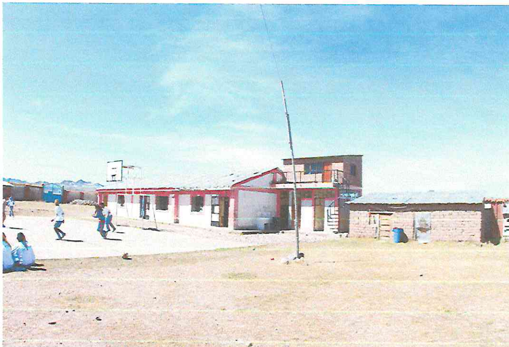
Foto: Cables alimentadores expuestos y sujetos provisionalmente
