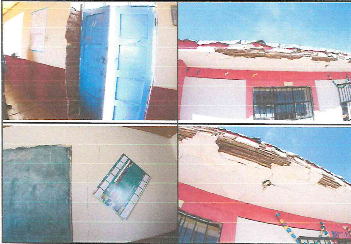
Imagen 5: Fotografías de las condiciones actuales del bloque 03.
