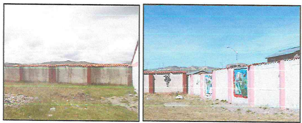
Imagen 13: Fotografía del cerco perimétrico de la Institución educativa.
