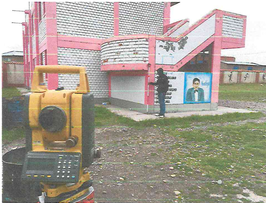
FOTO 07: Proceso de Levantamiento Topográfico T-01
