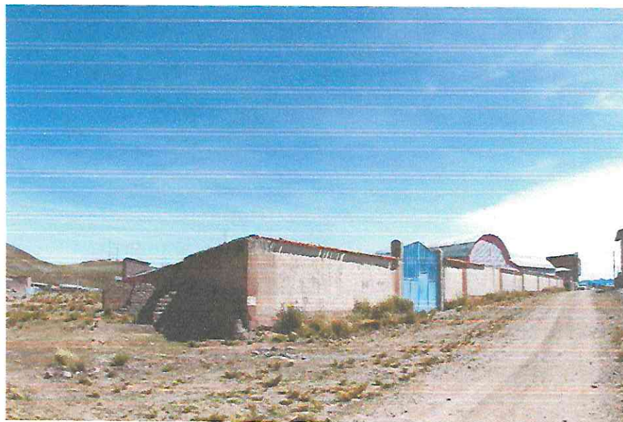
Fotografía N° 02: EL TERRENO SE ENCUENTRA AL FRENTE DE LA PUERTA POSTERIOR DEL TERRENO ACTUAL.
