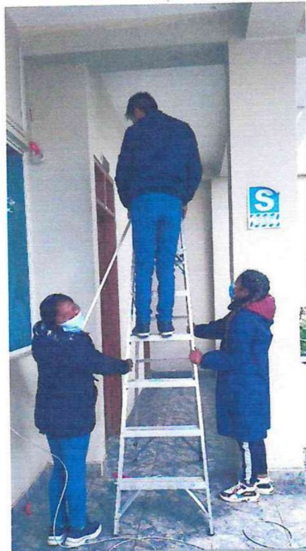
ILUSTRACIÓN 22 NUEVO CABLEADO DE RED CON CABLE UTP Y RENOVACIÓN DE CABLEADO EN OFICINAS DE LA ENTIDAD
