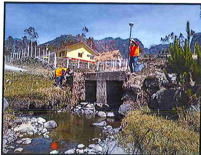
FOTO N° 08: Vista de la fuente de agua 04 00+000km (N:8470795.34 - E:315542.11)
