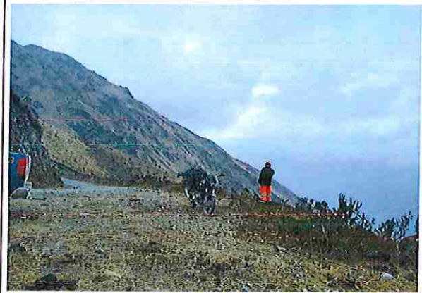
foto 02: KM 06 + 700 Patio de Máquina lado derecho.
