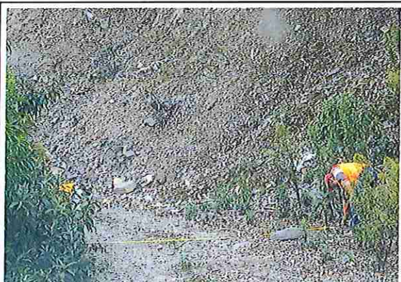
Foto 84: KM 04 + 150 Terreno ondulado con un ancho de superficie 4.02 m.
