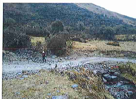
foto 110: KM 05 + 450 Terreno plano con un ancho de superficie de 4.08 m.
