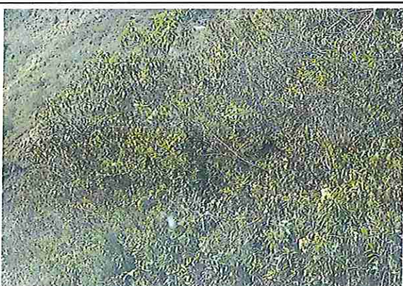
foto 305: KM 15 + 200 Terreno ondulado con un ancho de superficie de 3.99 m.
