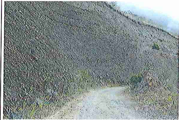
foto 56: KM 02 + 750 Terreno ondulado con un ancho de superficie 3.97 m.
