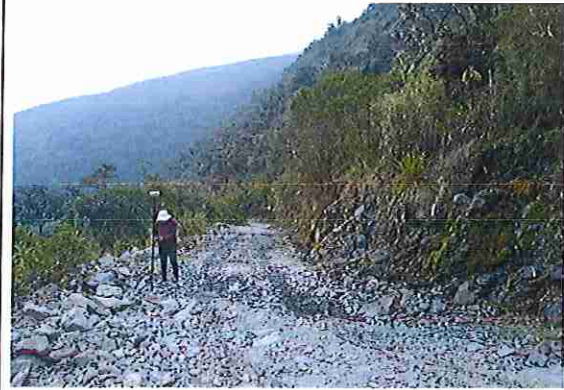
Foto 200: KM 09 + 950 Terreno ondulado con un ancho de superficie 3.97 m.
