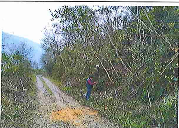
foto 71: KM 17 + 500, Ausencia de material de afirmado, con presencia de deformaciones y ahuellamiento.
