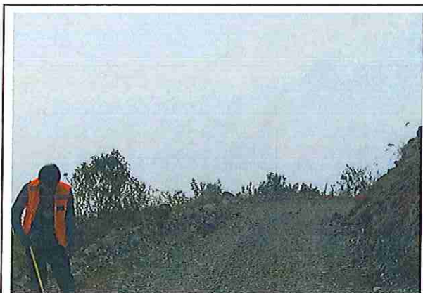
foto 173: KM 08 + 600 Terreno plano con un ancho de superficie 4.04 m.
