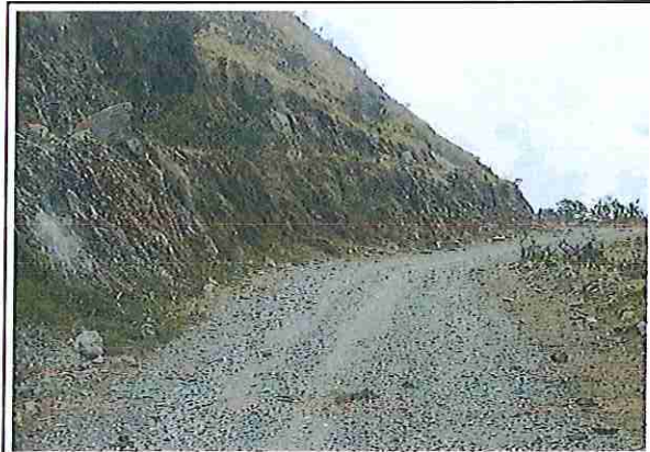
foto 140: KM 06 + 950 Terreno plano con un ancho de superficie 3.85 m.
