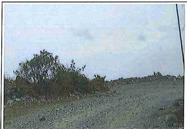
foto 174: KM 08 + 650 Terreno ondulado con un ancho de superficie 3.94 m.
