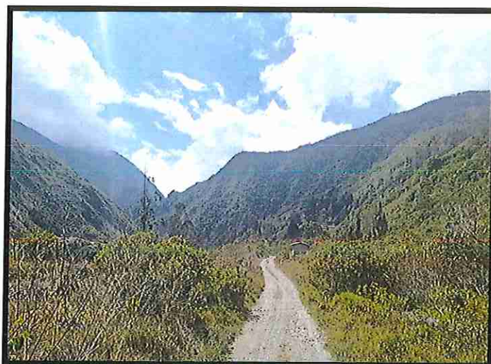
FOTO N° 21 Se puede apreciar el estado de la superficie de rodadura entre el Km 21 + 001- Km 22 + 000
