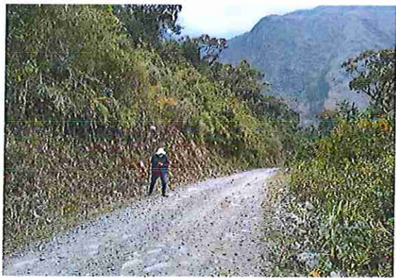
foto 286: KM 14 + 250, donde se puede observar que el camino vecinal esta encalaminado
