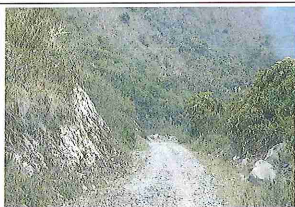
foto 281: KM 14 + 000 Terreno plano con un ancho de superficie de 4.08 m.
