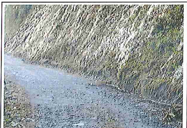
foto 180: KM 08 + 950 Terreno ondulado con un ancho de superficie 3.94 m.
