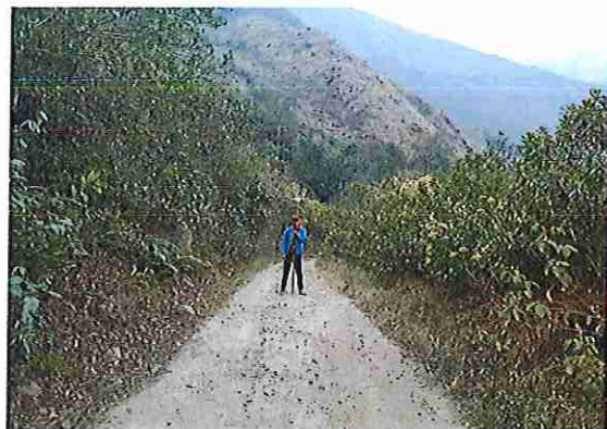
foto 408: KM 20 + 350 Terreno plano con un ancho de superficie de 4.08 m.
