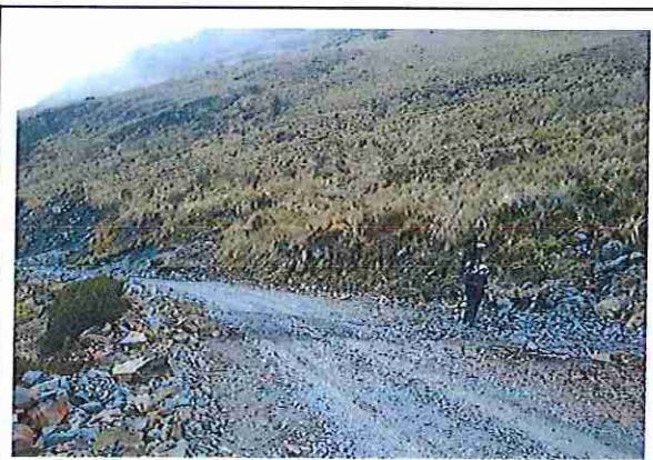
foto 116: KM 05 + 750 Terreno ondulado con un ancho de superficie 3.88 m.
