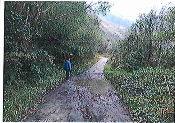
foto 362: KM 18 + 050, Ausencia de material de afirmado, con presencia de deformaciones y erosiones.
