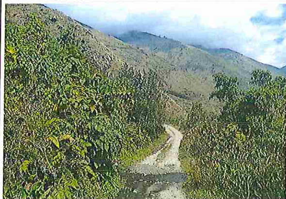
foto 423: KM 21 + 100 Terreno plano con un ancho de superficie de 4.03 m.
