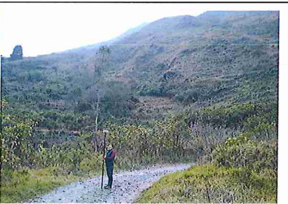
foto 348: KM 17 + 350 Terreno plano con un ancho de superficie de 4.08 m.
