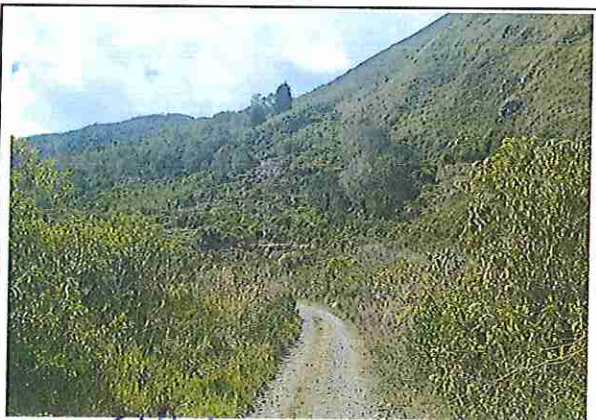
foto 84: KM 20 + 750, Ausencia de material de afirmado con presencia de deformaciones y erosiones.
