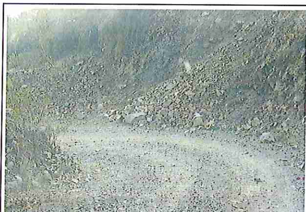
foto 265: KM 13 + 200, donde se puede observar que la capa de rodadura tiene baches y ausencia de material.
