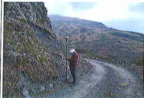
foto 144: KM 07 + 150, Talud margen Izq. Ausencia de material de afirmado, con presencia de deformaciones y erosiones.
