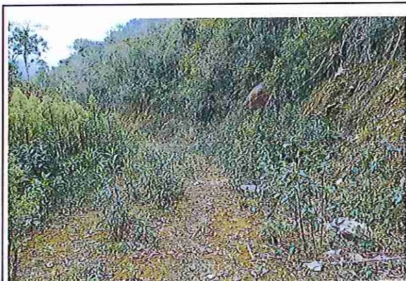
foto 121: KM 06 + 000 Terreno ondulado con un ancho de superficie 3.97 m.
