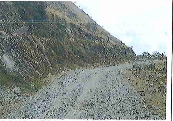
foto 120: KM 05 + 950 Terreno plano con un ancho de superficie 4.20 m.
