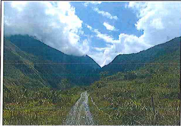
foto 444: KM 22 + 200 ,Ausencia de material de afirmado, con presencia de deformaciones y erosiones.
