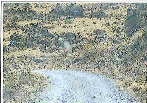
foto 101: KM 05 + 000 Terreno ondulado con un ancho de superficie 3.80 m.
