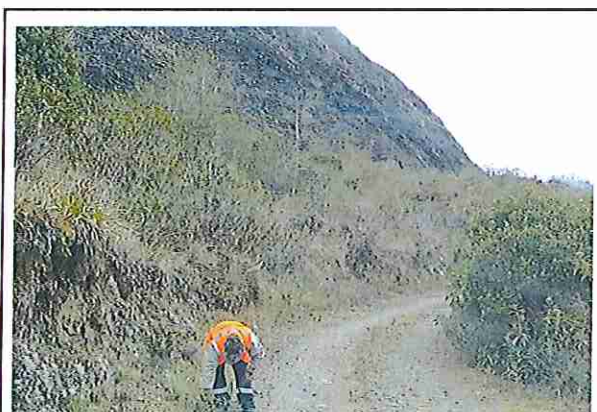
foto 18: KM 00 + 850 Terreno ondulado con un ancho de superficie 4.01 m.
