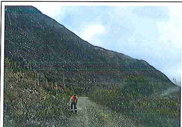
foto 16: KM 00 + 750 Terreno ondulado con un ancho de superficie 4.03 m.
