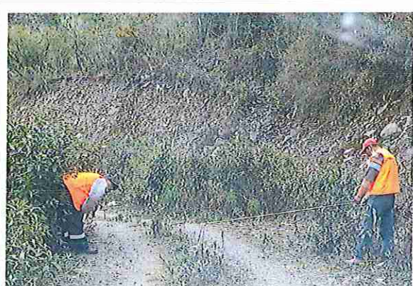
foto 87: KM 04 + 300 Terreno ondulado con un ancho de superficie 4.00 m.
