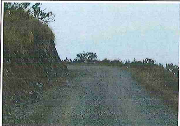
foto 165: KM 08 + 200 Terreno plano con un ancho de superficie de 4.08 m.
