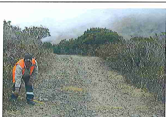
foto 47: KM 02 + 300 Terreno ondulado con un ancho de superficie 3.96 m.
