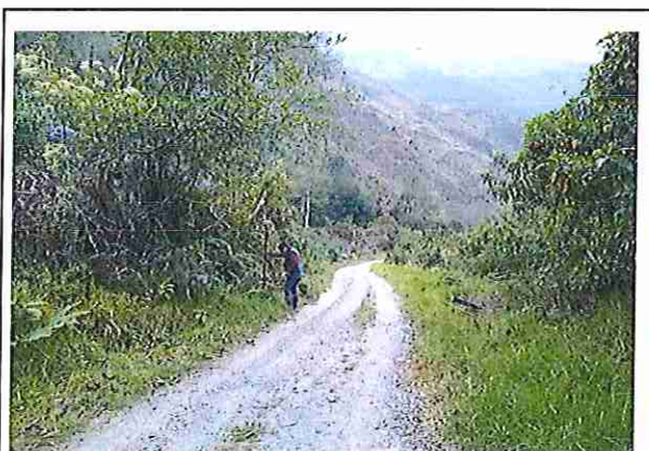
foto 383: KM 19 + 100 Terreno plano con un ancho de superficie 3.89 m.
