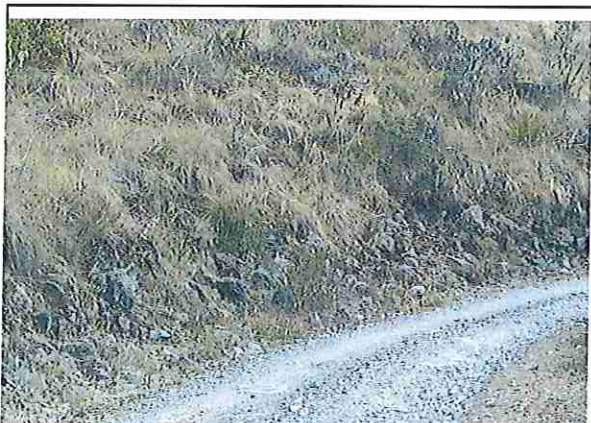
foto 167: KM 08 + 300 Terreno plano con un ancho de superficie 4.20 m.
