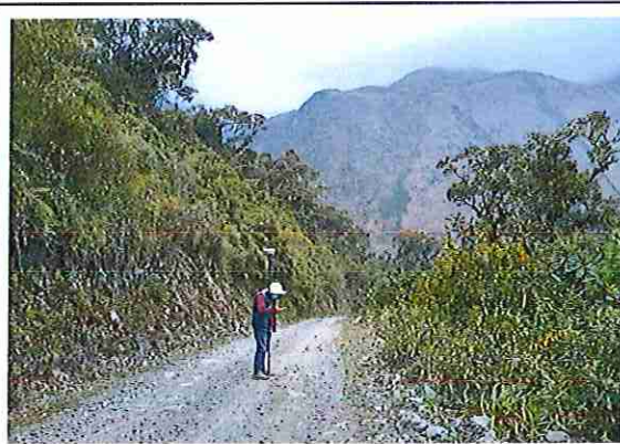
foto 284: KM 14 + 150 Terreno plano con un ancho de superficie de 4.03 m.
