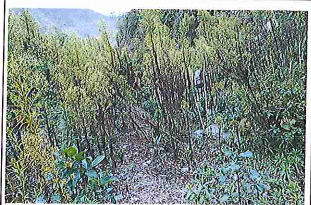
foto 124: KM 06 + 150, Ausencia de material de afirmado, con presencia de deformaciones y erosiones
