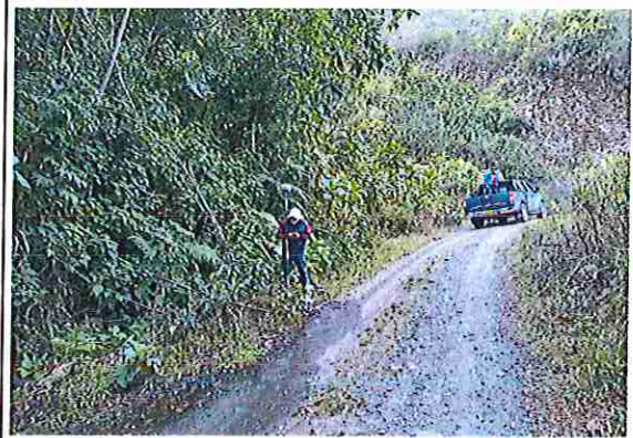
foto 398: KM 19 + 850 Terreno plano con un ancho de superficie 3.89 m.
