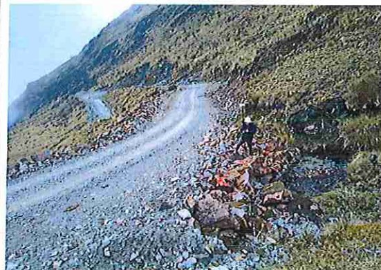
foto 82: KM 04 + 050 Terreno plano con un ancho de superficie 3.89 m.
