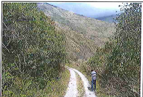
foto 449: KM 22 + 450 Terreno plano con un ancho de superficie de 4.08 m.
