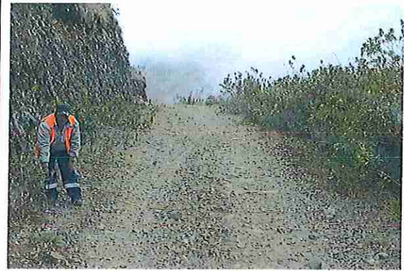
foto 26: KM 01 + 250 Terreno plano con un ancho de superficie 4.07 m.
