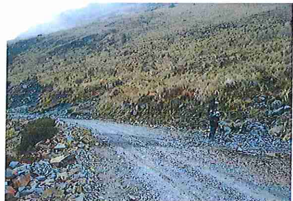
foto 122: KM 06 + 050 Terreno plano con un ancho de superficie 3.85 m.
