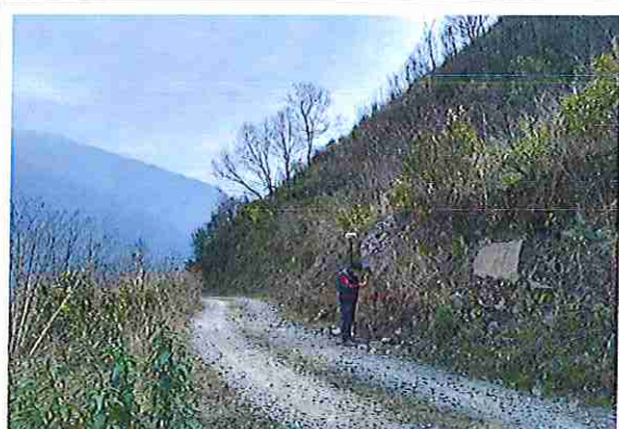
foto 395: KM 19 + 700 Terreno plano con un ondulado de superficie 4.04 m.
