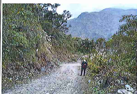
foto 204: KM 10 + 150 Terreno ondulado con un ancho de superficie 3.94 m.
