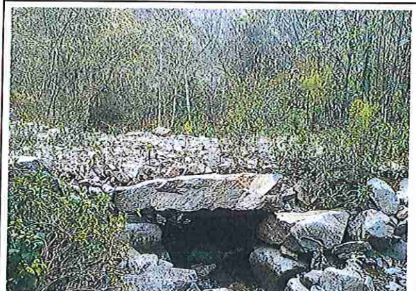
foto 06: KM 04 + 710 Fuente de agua lado derecho.
