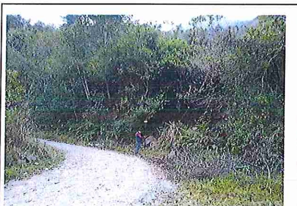
foto 382: KM 19 + 050 Terreno plano con un ancho de superficie de 4.03 m.
