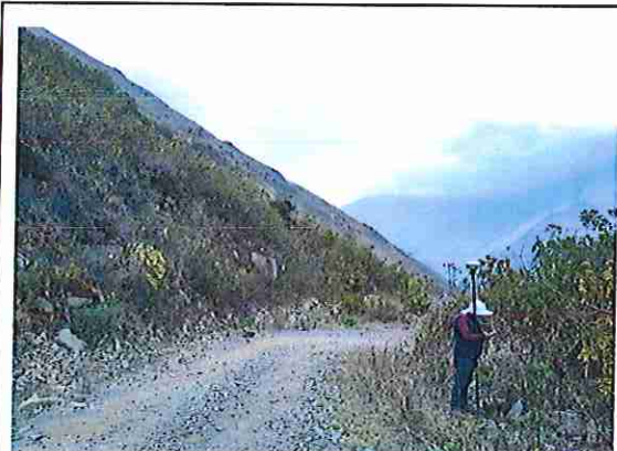
foto 336: KM 16 + 750, Ausencia de material de afirmado, con presencia de deformaciones y ahuellamiento.
