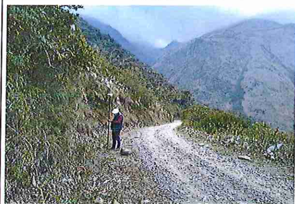
foto 202: KM 10 + 050 Terreno plano con un ancho de superficie 4.20 m.
