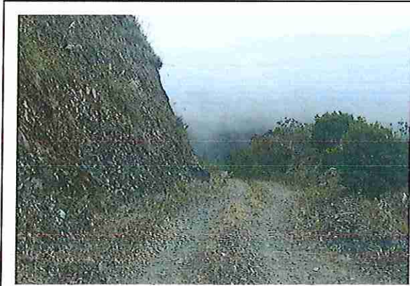
foto 79: KM 03 + 900 Terreno plano con un ancho de superficie 3.99 m.
