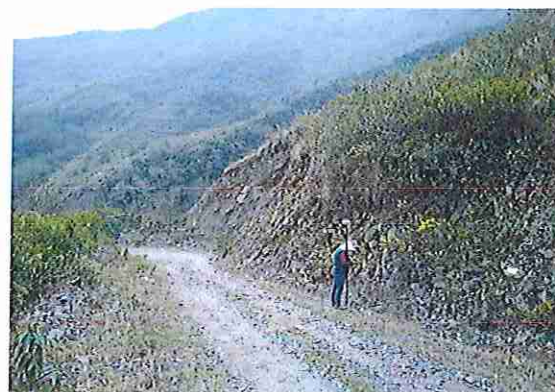
foto 218: KM 10 + 850 Terreno ondulado con un ancho de superficie 3.93 m.
