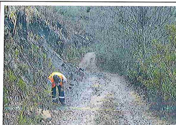
foto 08: KM 00 + 0350 Terreno accidentado con un ancho de superficie 3.92 m.
