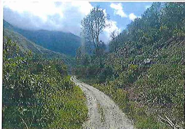
foto 393: KM 19 + 600 Terreno plano con un ancho de superficie 3.89 m.
