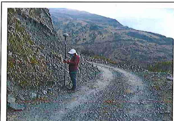
foto 271: KM 13 + 500, donde se puede observar que la capa de rodadura tiene baches y ausencia de material.
