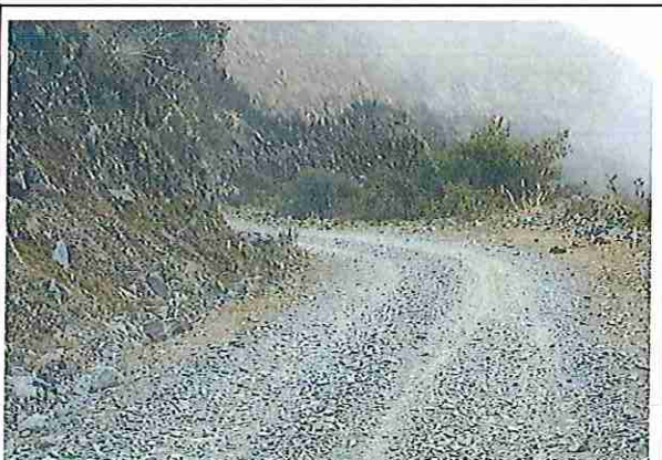
foto 106: KM 05 + 250 Terreno plano con un ancho de superficie 4.20 m.
