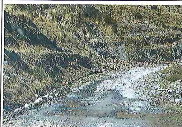
foto 56: KM 02 + 750 Terreno ondulado con un ancho de superficie 3.88 m.
