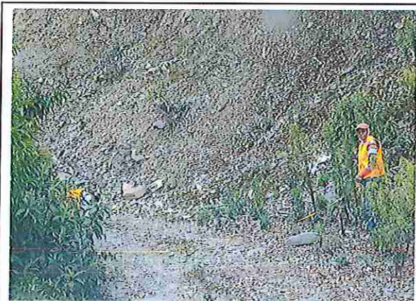
foto 85: KM 04 + 200, donde se puede observar que tiene la capa de rodadura tiene erosión
