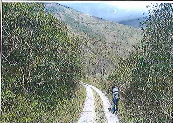
foto 405: KM 20 + 200 Terreno plano con un ancho de superficie 3.89 m.
