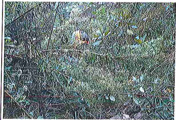
foto 157: KM 07 + 850, Ausencia de material de afirmado, con presencia de deformaciones y erosiones
