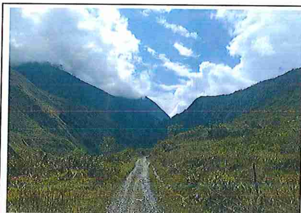
foto 421: KM 21 + 000, Ausencia de material de afirmado, con presencia de deformaciones y erosiones.
