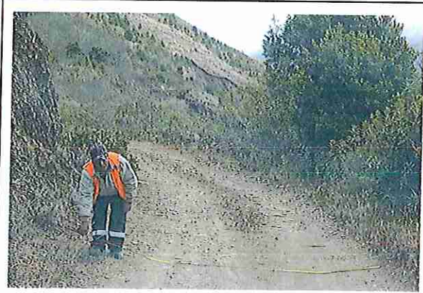
foto 19: KM 00 + 900 Terreno plano con un ancho de superficie 4.08 m.
