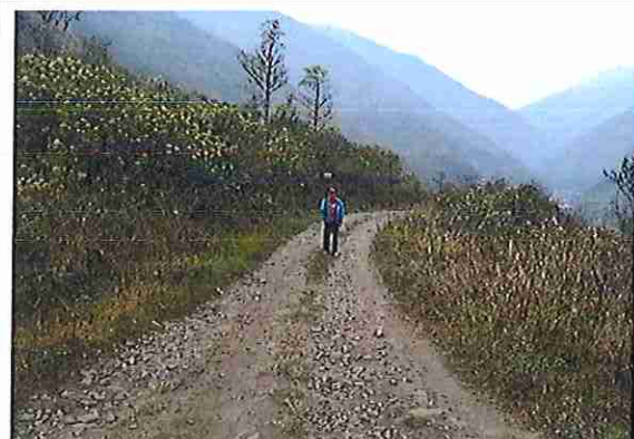
foto 234: KM 11 +650, talud margen Izq. Ausencia de material de afirmado, con presencia de deformaciones y erosiones.
