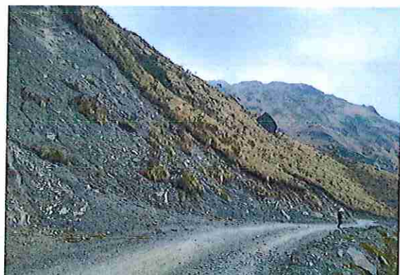
foto 75: KM 03 + 700 Terreno ondulado con un ancho de superficie 3.80 m.
