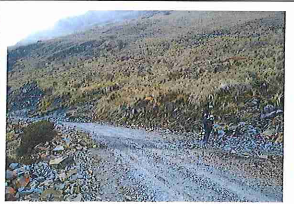
foto 42: KM 02 + 050, Ausencia de material de afirmado, con presencia de deformaciones y erosiones.
