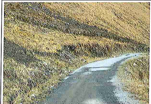
foto 02: KM 00 + 050 Terreno plano con un ancho de superficie de 4.08 m.
