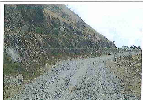
foto 105: KM 05 + 200 Terreno plano con un ancho de superficie de 4.08 m.
