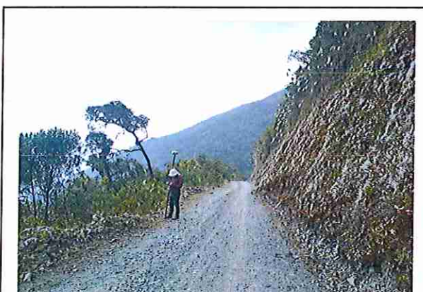
foto 275: KM 13 + 700 Terreno plano con un ancho de superficie de 4.08 m.
