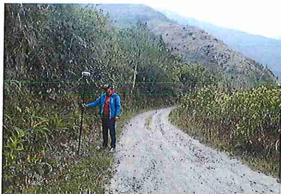
foto 255: KM 12 + 700 Terreno plano con un ancho de superficie de 4.01 m.
