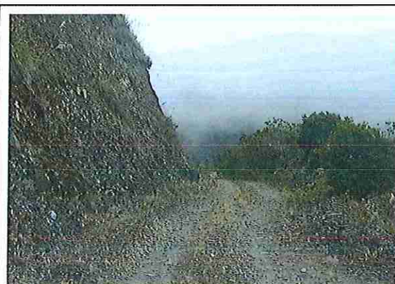
foto 62: KM 03 + 050 Terreno plano con un ancho de superficie 3.94 m.
