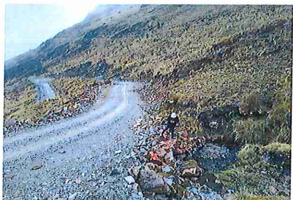
foto 35: KM 01 + 700 Terreno plano con un ancho de superficie 3.85 m.
