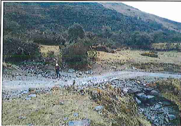
foto 21: tajea KM 16 + 040, se encuentra en buen estado, pero requiere de limpieza
