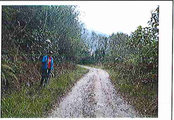
foto 310: KM 15 + 450 Terreno plano con un ancho de superficie de 4.08 m.
