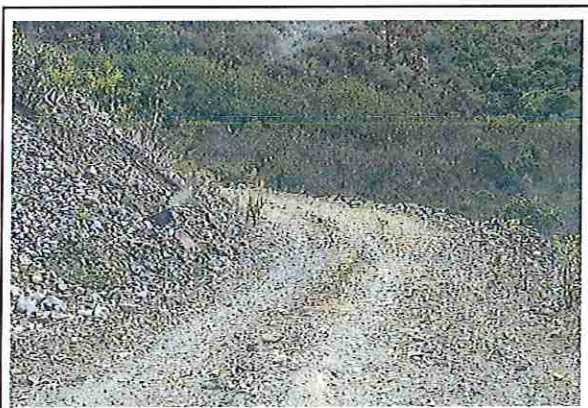
foto 66: KM 03 + 250 Terreno plano con un ancho de superficie 3.96 m.
