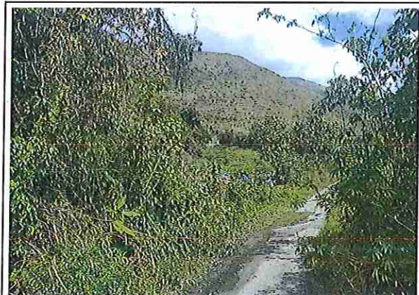
foto 422: KM 21 + 050 Terreno plano con un ancho de superficie de 4.08 m.
