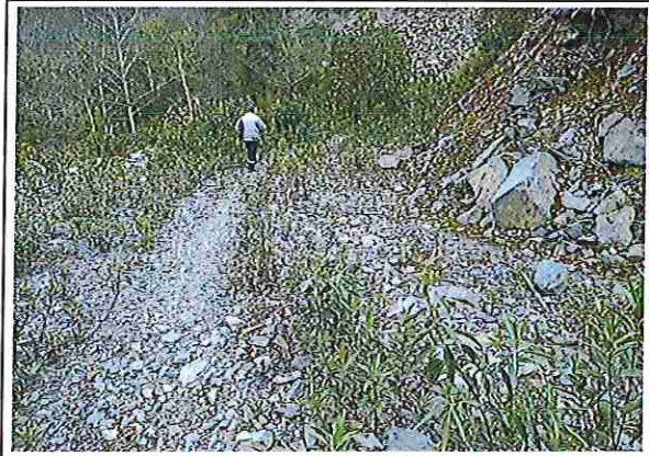
Foto 94: KM 04 + 650 Terreno ondulado con un ancho de superficie 4.01 m.
