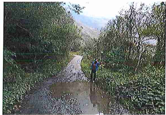
foto 250: KM 12 + 450, Ausencia de material de afirmado, con presencia de deformaciones y ahuellamiento.
