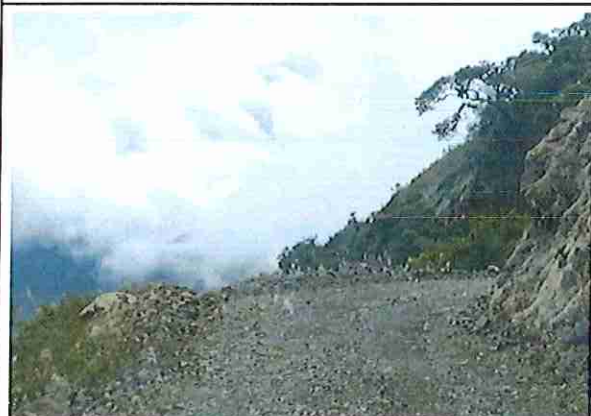
foto 221: KM 11 + 000 Terreno ondulado con un ancho de superficie 4.00 m.
