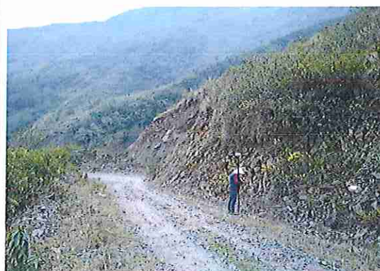
foto 330: KM 16 + 450 Terreno plano con un ancho de superficie de 4.03 m.
