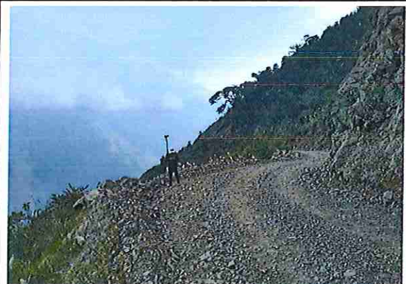
foto 162: KM 08 + 050 Terreno plano con un ancho de superficie 4.20 m.
