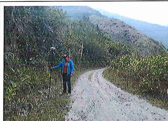
foto 340: KM 16 + 950, Ausencia de material de afirmado, con presencia de deformaciones y ahuellamiento.
