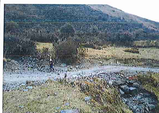
foto 60: KM 02 + 950 Terreno plano con un ancho de superficie 3.89 m.
