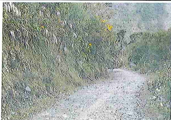
foto 257: KM 12 + 800 Terreno plano con un ancho de superficie de 4.04 m.
