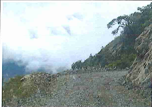
foto 221: KM 11 + 000, donde se puede observar que la capa de rodadura tiene baches y ausencia de material.
