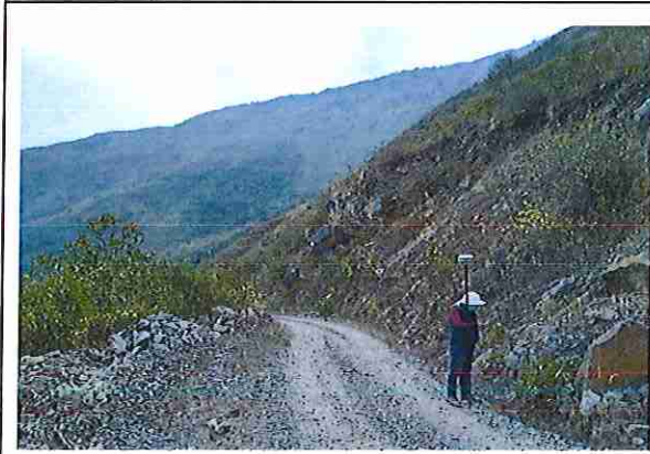
foto 331: KM 16 + 500 Terreno plano con un ancho de superficie de 4.08 m.
