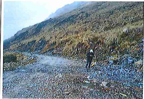
foto 32: KM 01 + 550 Terreno accidentado con un ancho de superficie 3.74 m.
