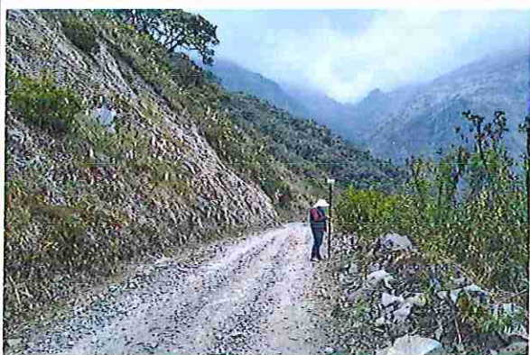
foto 327: KM 16 + 300 Terreno plano con un ancho de superficie de 4.03 m.
