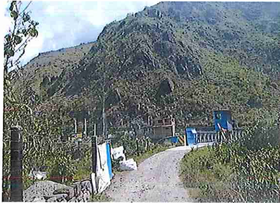
Progresiva 07+924 km Camatani
