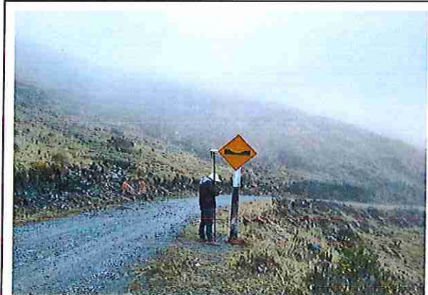
FOTO N°01: SEÑAL PREVENTIVA 02 + 030, estado regular. Falta pintura.
