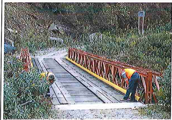
Foto 82: KM 04 + 050 Terreno ondulado con un ancho de superficie 4.00 m.
