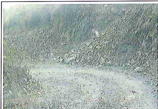
foto 265: KM 13 + 200 Terreno accidentado con un ancho de superficie de 3.98 m.
