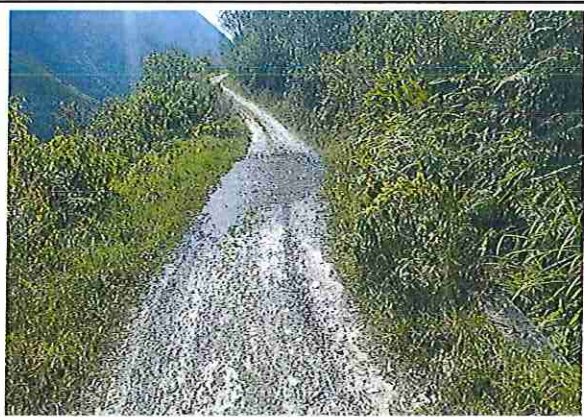
foto 413: KM 20 + 600 Terreno plano con un ancho de superficie de 4.03 m.
