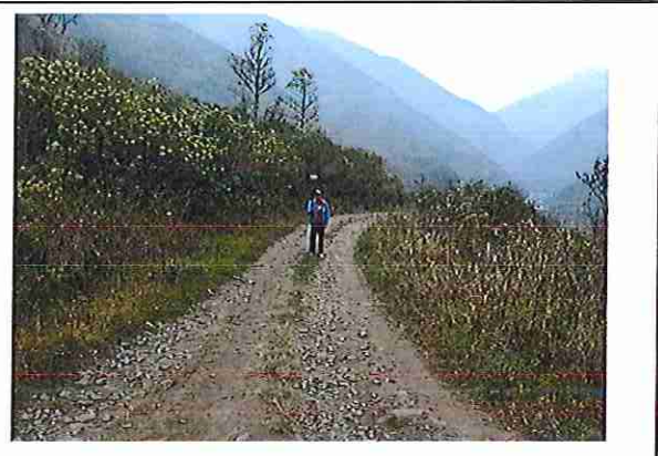
foto 308: KM 15 + 350 Terreno ondulado con un ancho de superficie de 3.96 m.
