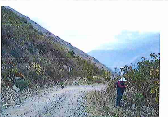
foto 336: KM 16 + 750 Terreno plano con un ondulado de superficie 3.98 m.
