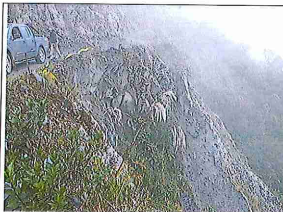
Tramo Quehani – Camatani Foto n° 1: DESLIZAMIENTO, zona de derrumbe de la vía 18 + 500
