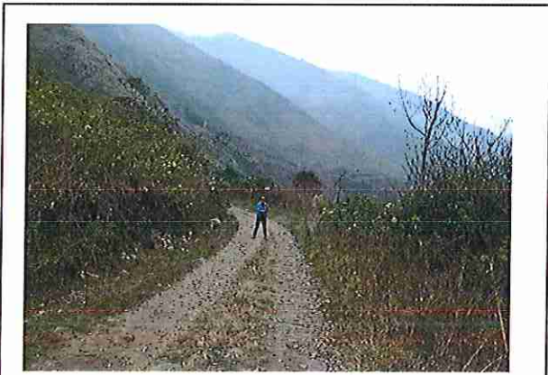
foto 307: KM 15 + 300, Ausencia de material de afirmado, con presencia de deformaciones y erosiones
