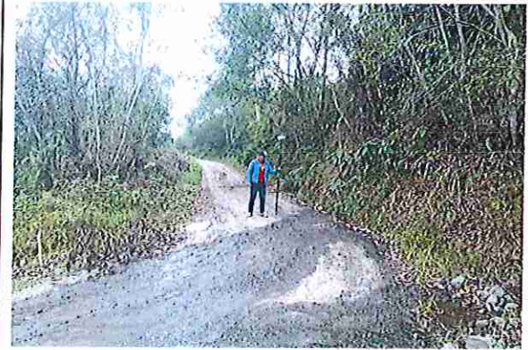
foto 388: KM 19 + 350 Terreno plano con un ancho de superficie de 4.08 m.
