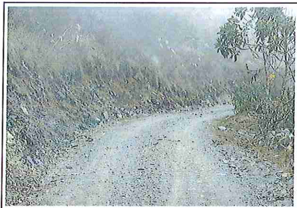
foto 158: KM 07 + 850 Terreno plano con un ancho de superficie de 4.08 m.
