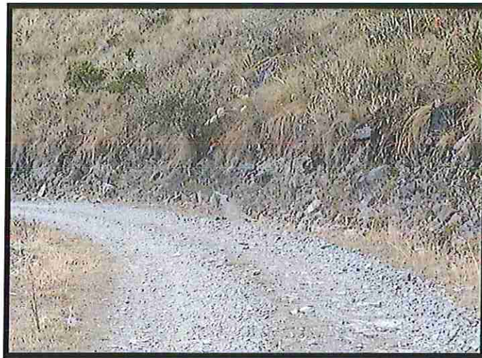
FOTO N° 07 Se puede apreciar el estado de la superficie de rodadura entre el Km 6 + 001- Km 7 + 000
