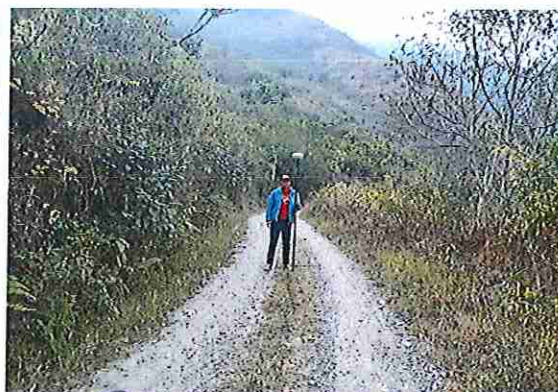
foto 258: KM 12 + 850 Terreno plano con un ancho de superficie de 4.02 m.
