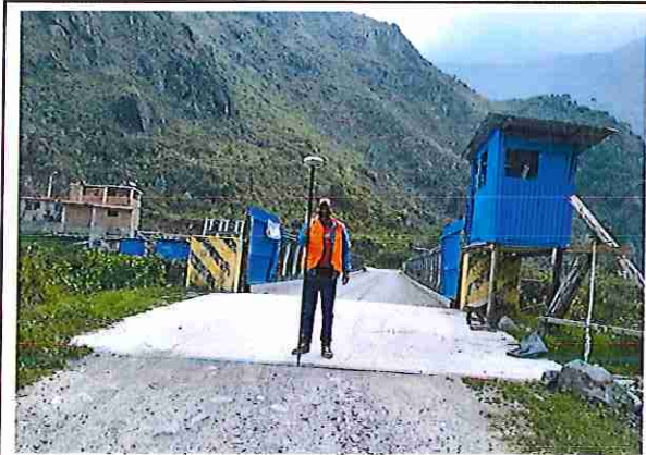
foto 01: KM 0+010; Puente Pumachaca.
