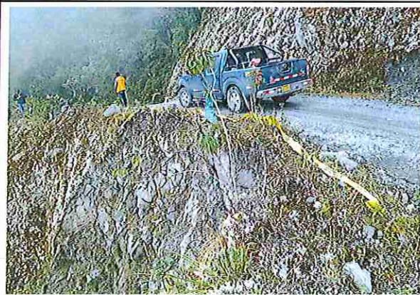
foto 201: KM 10 + 000 Terreno ondulado con un ancho de superficie 3.97 m.
