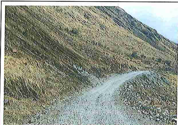
foto 73: KM 03 + 600 Terreno ondulado con un ancho de superficie 3.88 m.
