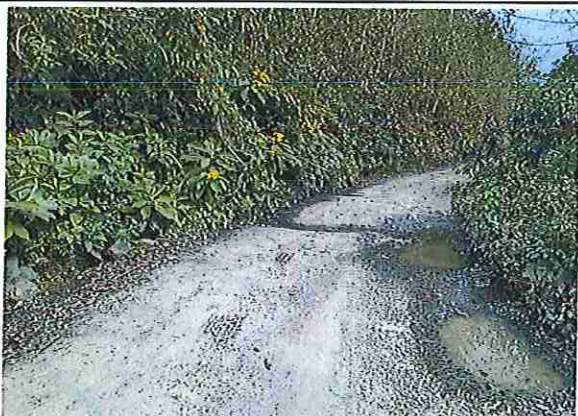
foto 23: baden KM 18+860, se encuentra en buen estado, pero requiere de limpieza
