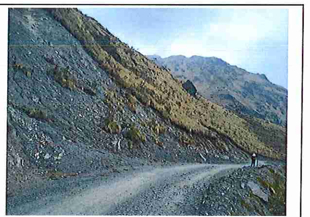
foto 12: KM 00 + 550 Terreno ondulado con un ancho de superficie 4.04 m.
