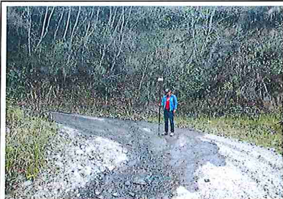
foto 182: KM 09 + 050 Terreno ondulado con un ancho de superficie 3.97 m.
