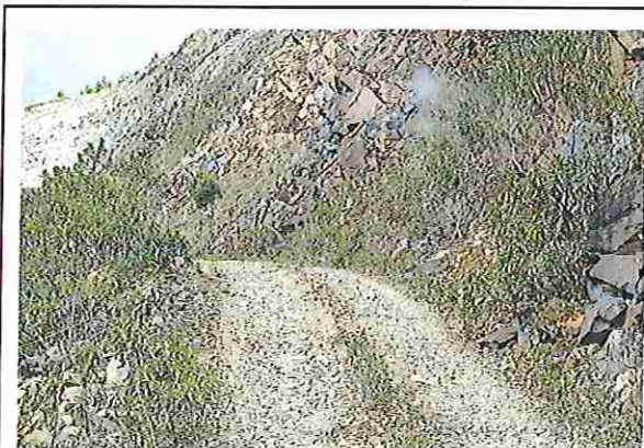
foto 51: KM 02 + 500 Terreno ondulado con un ancho de superficie 3.97 m.
