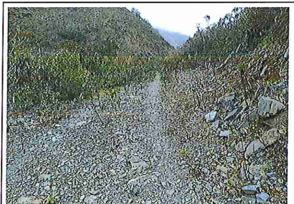
Foto 96: KM 04 + 750 Terreno ondulado con un ancho de superficie 4.02 m.
