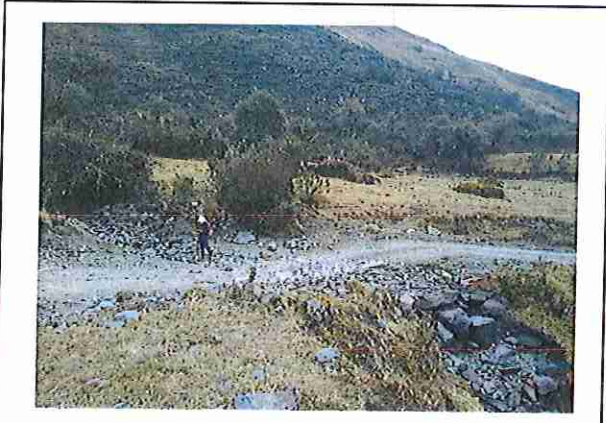
foto 115: KM 05 + 700, Ausencia de material de afirmado, con presencia de deformaciones y erosiones.
