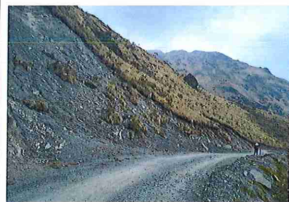
foto 90: KM 04 + 450 Terreno ondulado con un ancho de superficie 3.80 m.
