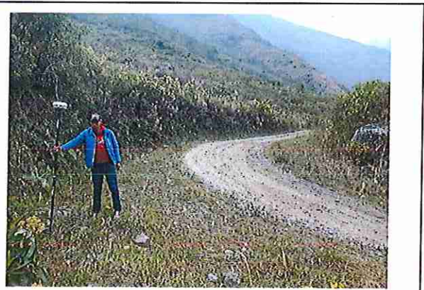
foto 260: KM 12 + 950 Terreno plano con un ancho de superficie de 4.04 m.
