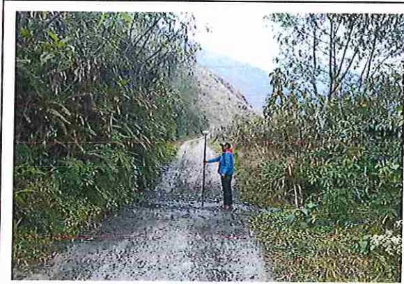
foto 439: KM 21 + 900 Terreno plano con un ancho de superficie de 4.03 m.
