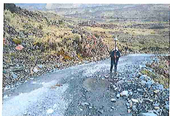
foto 59: KM 02 + 900 Terreno plano con un ancho de superficie de 4.08 m.
