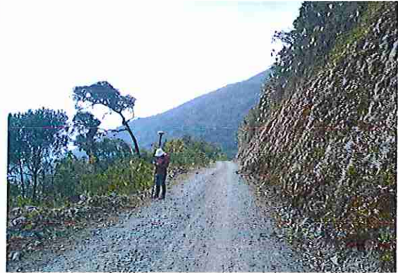
foto 146: KM 07 + 250 Terreno ondulado con un ancho de superficie 4.04 m.
