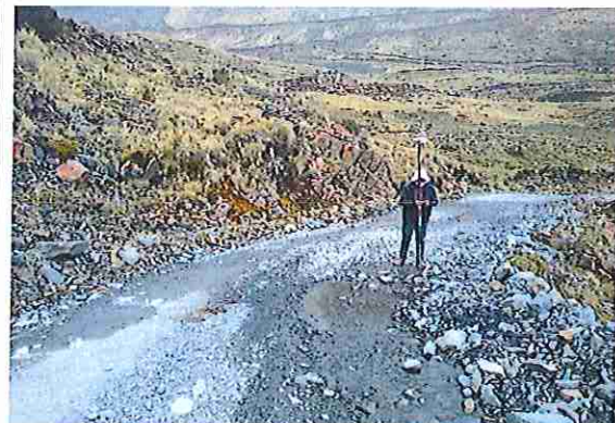
foto 96: KM 04 + 750 Terreno ondulado con un ancho de superficie 3.80 m.
