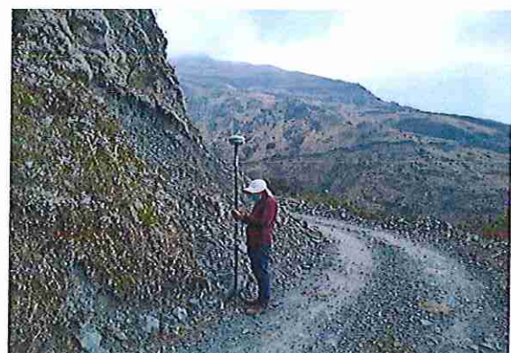
foto 131: KM 06 + 500 Terreno ondulado con un ancho de superficie 3.94 m.
