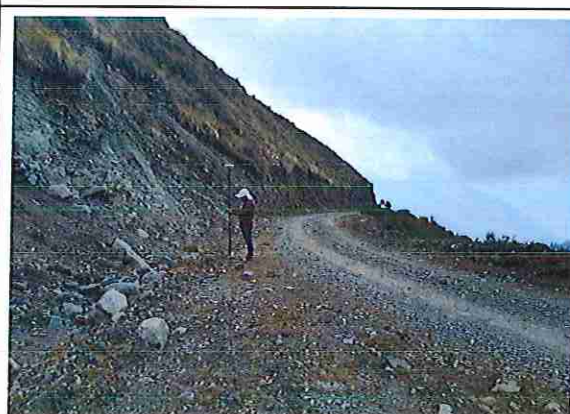
foto 28: KM 01 + 350 Terreno plano con un ancho de superficie 3.89 m.
