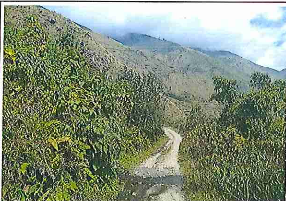
foto 442: KM 22 + 100 Terreno plano con un ancho de superficie de 4.02 m.
