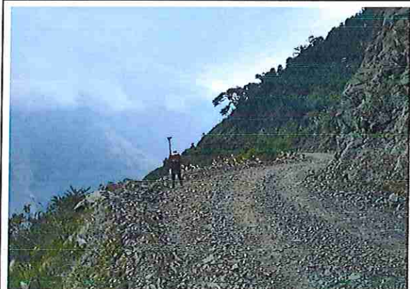
foto 154: KM 07 + 650 Terreno ondulado con un ancho de superficie 3.80 m.
