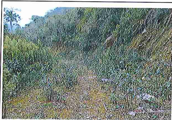
foto 121: KM 06 + 000, Ausencia de material de afirmado, con presencia de deformaciones y erosiones
