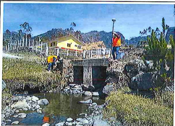
foto 05: KM 04 + 000 Fuente de agua lado derecho.
