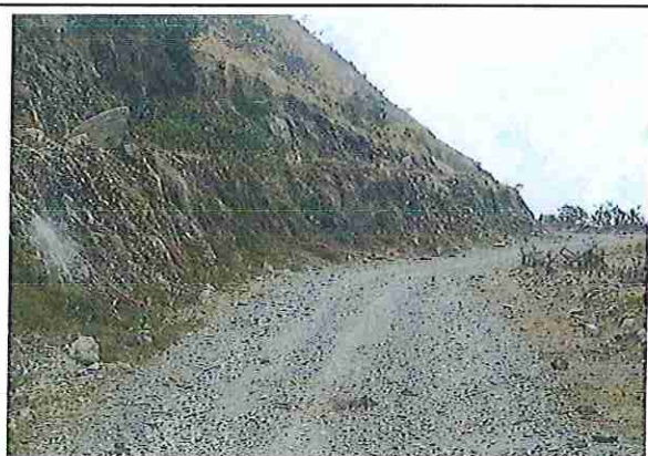
foto 111: KM 05 + 500 Terreno ondulado con un ancho de superficie 3.80 m.
