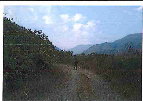
foto 342: KM 17 + 050 Terreno plano con un ancho de superficie de 4.03 m.
