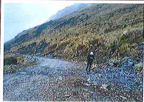
foto 68: KM 03 + 350 Terreno ondulado con un ancho de superficie 3.80 m.
