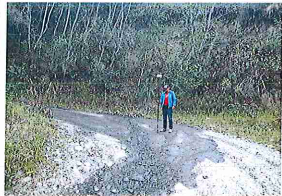
foto 364: KM 18 + 150 Terreno plano con un ondulado de superficie 3.96 m.
