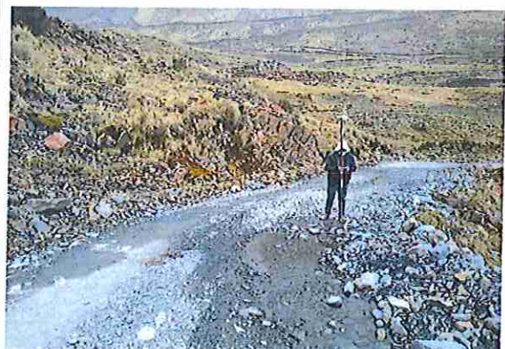
foto 96: KM 04 + 750, Ausencia de material de afirmado, con presencia de deformaciones y erosiones.
