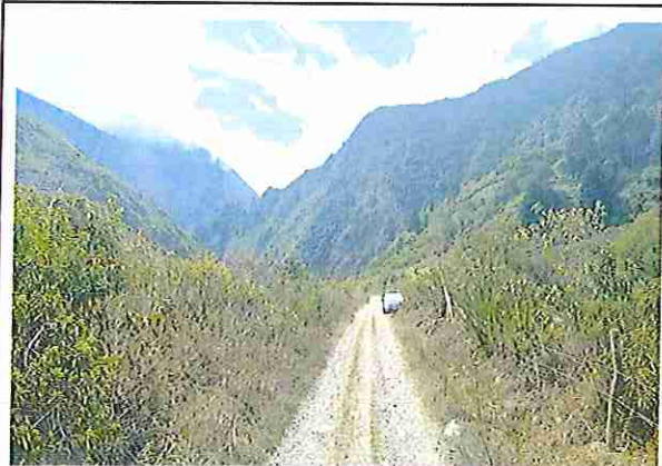
foto 441: KM 22 + 000 Terreno plano con un ancho de superficie de 4.05 m.
