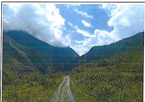
foto 430: KM 21 + 450 Terreno plano con un ancho de superficie de 4.03 m.
