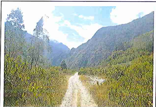
foto 445: KM 22 + 250 Terreno plano con un ancho de superficie de 4.03 m.
