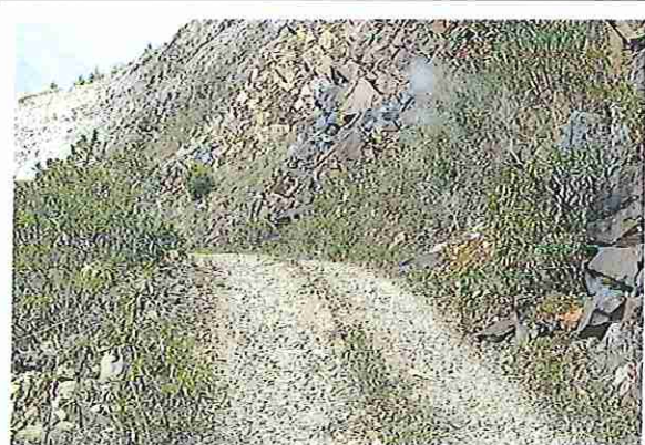
foto 69: KM 03 + 400 Terreno plano con un ancho de superficie 3.96 m.
