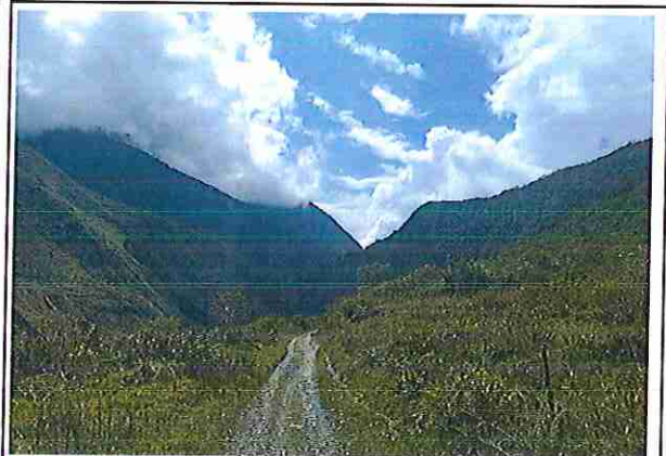
foto 430: KM 21 + 450, Ausencia de material de afirmado, con presencia de deformaciones y erosiones.
