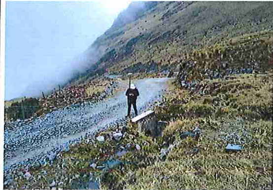
foto 62: KM 03 + 050 Terreno ondulado con un ancho de superficie 3.80 m.
