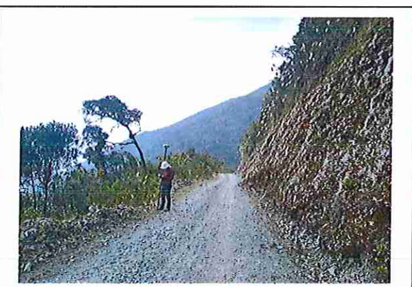
foto 274: KM 13 + 650 Terreno plano con un ancho de superficie de 4.08 m.
