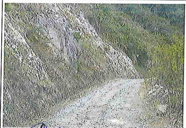
foto 48: KM 11 + 750, Talud margen Izq. Ausencia de material de afirmado, con presencia de deformaciones y erosione
