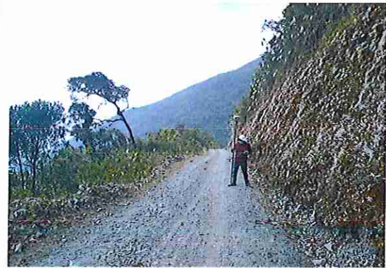
foto 152: KM 07 + 550 Terreno plano con un ancho de superficie 3.85 m.
