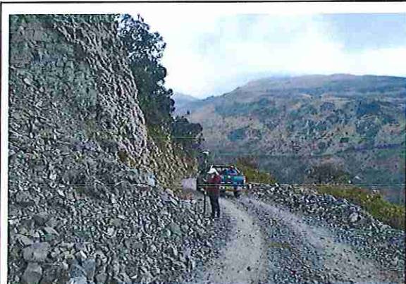
foto 279: KM 13 + 900 Terreno plano con un ancho de superficie de 4.08 m.
