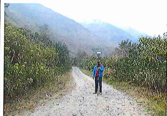
foto 296: KM 14 + 750 Terreno ondulado con un ancho de superficie de 3.99 m.
