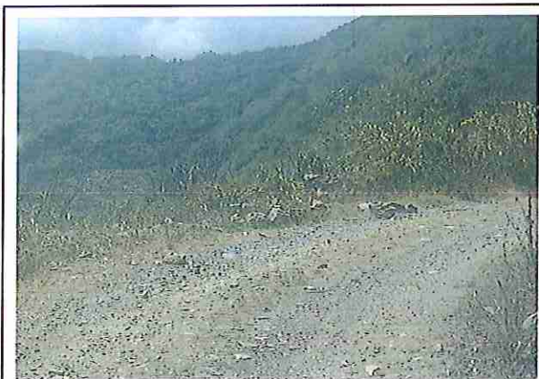
foto 337: KM 16 + 800, Ausencia de material de afirmado, con presencia de deformaciones y erosiones.
