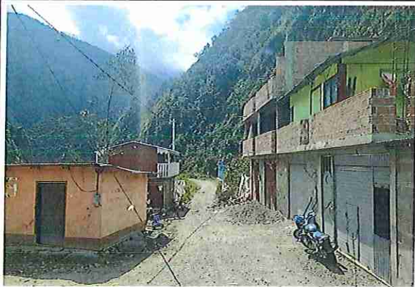
foto 452: KM 22 + 570 Terreno plano con un ancho de superficie de 4.08 m.
