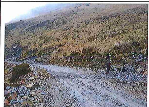
foto 16: Tajea KM 09 + 860 en regular estado, pero requiere limpieza.
