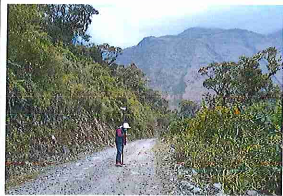
foto 284: KM 14 + 150, donde se puede observar que el camino vecinal esta encalaminado
