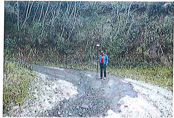
foto 386: KM 19 + 250 Terreno plano con un ancho de superficie de 4.03 m.
