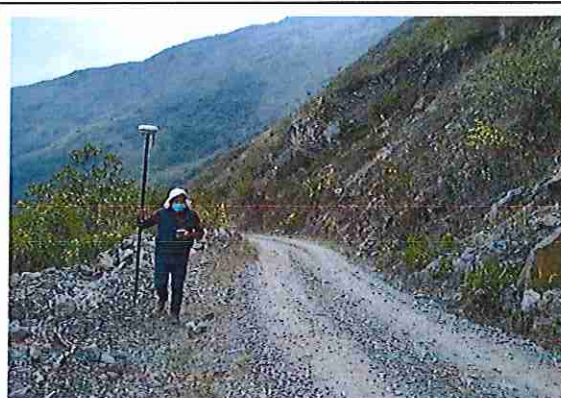
foto 326: KM 16 + 250 Terreno plano con un ancho de superficie de 4.02 m.
