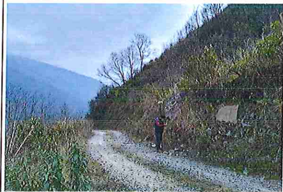
foto 394: KM 19 + 650 Terreno plano con un ancho de superficie de 4.03 m.
