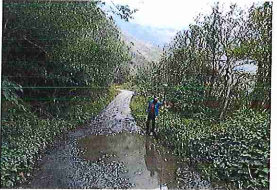
foto 250: KM 12 + 450 Terreno ondulado con un ancho de superficie 3.91 m.
