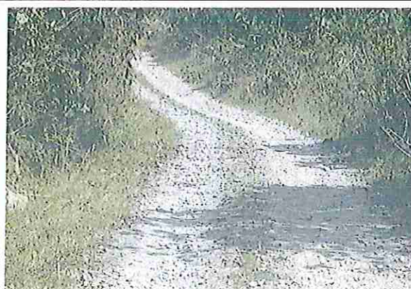
foto 345: KM 17 + 200 Terreno plano con un ondulado de superficie 3.92 m.
