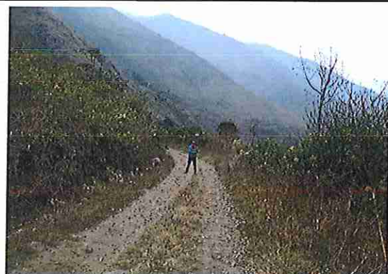
foto 288: KM 14 + 350, donde se puede observar que el camino vecinal esta encalaminado
