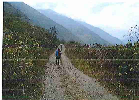
foto 256: KM 12 + 750 Terreno plano con un ancho de superficie de 4.03 m.
