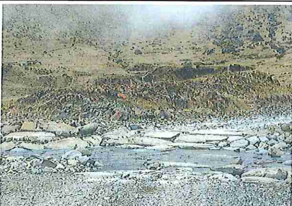
foto 17: KM 04 + 000,Ausencia de material de afirmado, con presencia de deformaciones y erosiones.
