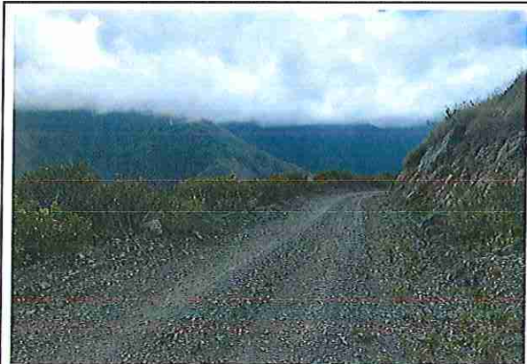
foto 289: KM 14 + 400 Terreno ondulado con un ancho de superficie de 3.99 m.
