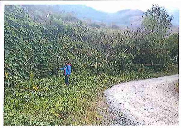
foto 282: KM 14 + 050, donde se puede observar que el camino vecinal esta encalaminado
