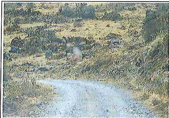
foto 170: KM 08 + 450 Terreno ondulado con un ancho de superficie 3.94 m.
