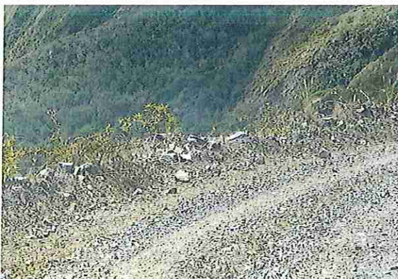
foto 297: KM 14 + 800 Terreno ondulado con un ancho de superficie de 3.99 m.
