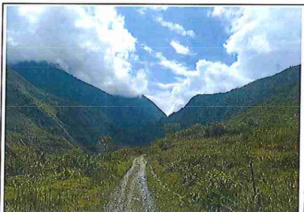
foto 438: KM 21 + 850 Terreno plano con un ancho de superficie de 4.03 m.
