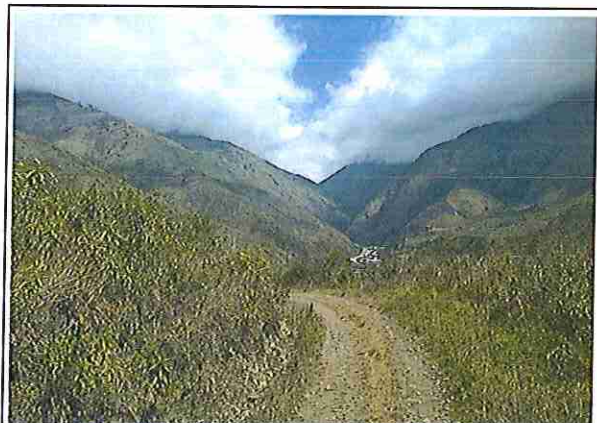
foto 78: KM 19 + 250, Ausencia de material de afirmado, erosiones por falta de baden.
