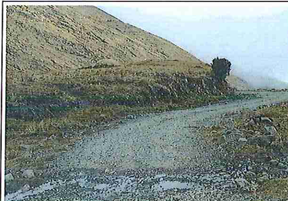
foto 88: KM 04 + 350 Terreno plano con un ancho de superficie 3.89 m.
