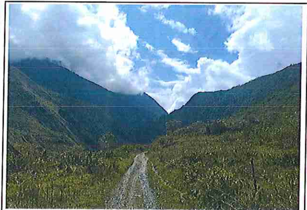
foto 438: KM 21 + 850, Ausencia de material de afirmado, con presencia de deformaciones y erosiones.
