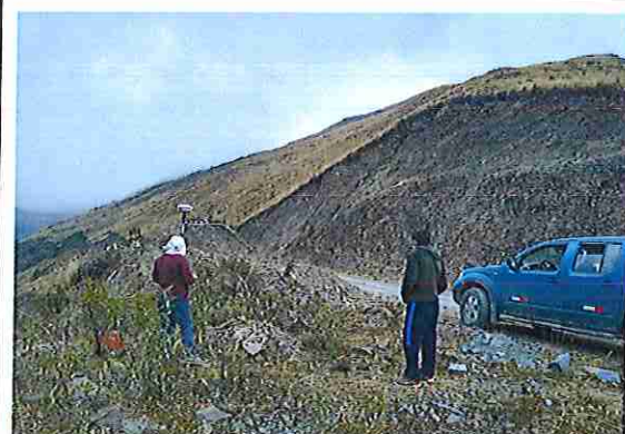
foto 72: KM 03 + 550 Terreno plano con un ancho de superficie de 4.08 m.
