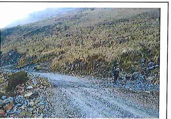
foto 42: KM 02 + 050 Terreno plano con un ancho de superficie 3.89 m.
