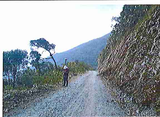
foto 280: KM 13 + 950 Terreno plano con un ancho de superficie de 4.07 m.
