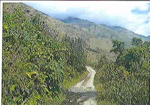
foto 377: KM 18 + 800 Terreno plano con un ancho de superficie de 4.08 m.
