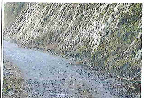
foto 164: KM 08 + 150 Terreno ondulado con un ancho de superficie 3.94 m.
