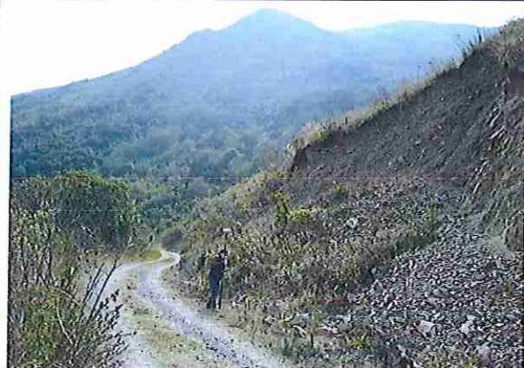
foto 320: KM 15 + 950 Terreno plano con un ancho de superficie de 4.01 m.
