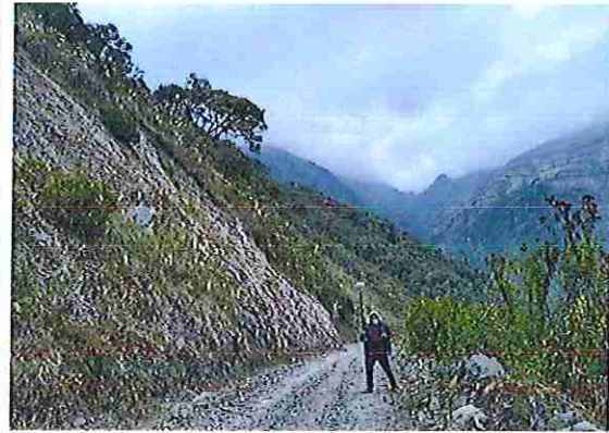
foto 206: KM 10 + 250 Terreno accidentado con un ancho de superficie 3.56 m.
