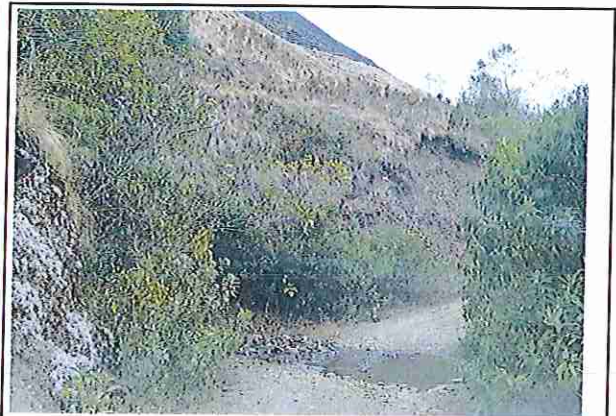
foto 22: KM 01 + 050 Terreno plano con un ancho de superficie 4.05 m.
