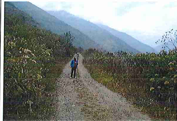
foto 226: KM 11 + 250 Terreno ondulado con un ancho de superficie 3.92 m.
