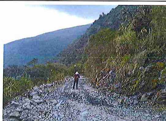
foto 268: KM 13 + 350, donde se puede observar que la capa de rodadura tiene baches y ausencia de material.
