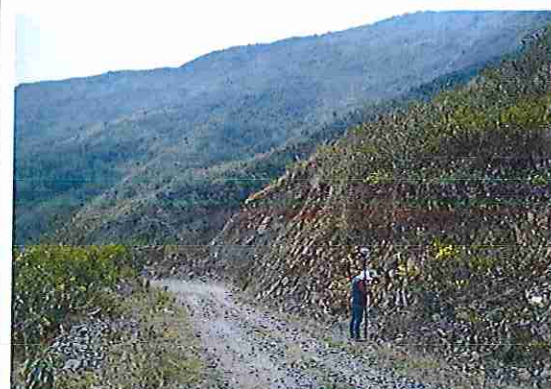
foto 220: KM 10 + 950 Terreno accidentado con un ancho de superficie 4.00 m.
