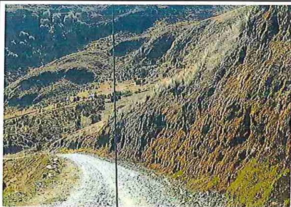
foto 51: KM 02 + 500 Terreno plano con un ancho de superficie 4.20 m.
