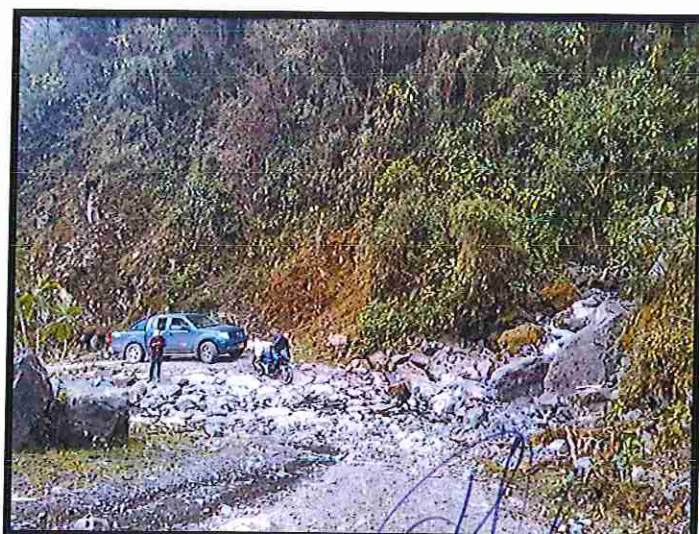
FOTO N° 06: Vista de la fuente de agua 02 09+000km (N:8478252.26 - E:344049.16)
