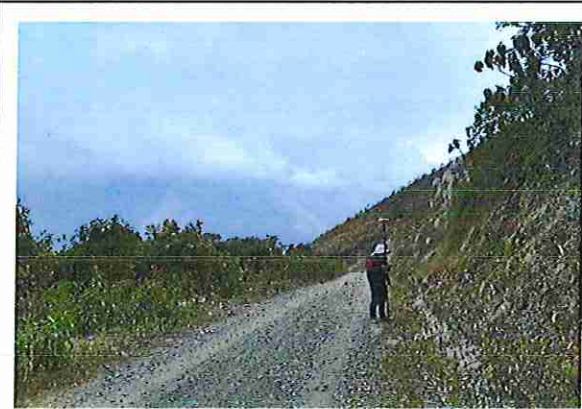
foto 291: KM 14 + 500 Terreno ondulado con un ancho de superficie de 3.99 m.
