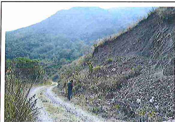
foto 399: KM 19 + 900 Terreno plano con un ancho de superficie de 4.03 m.
