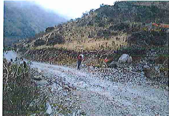
foto 64: KM 03 + 150 Terreno plano con un ancho de superficie de 4.08 m.
