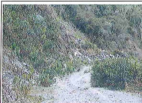
Foto 86: KM 04 + 250 Terreno ondulado con un ancho de superficie 4.03 m.
