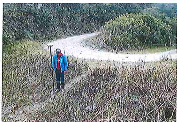
foto 243: KM 12 + 100 Terreno plano con un ancho de superficie de 4.08 m.
