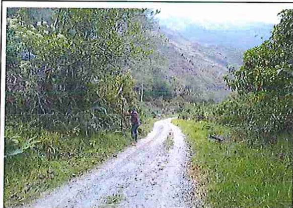
foto 76: KM 18 + 750, Ausencia de material de afirmado, con presencia de deformaciones y ahuellamiento.
