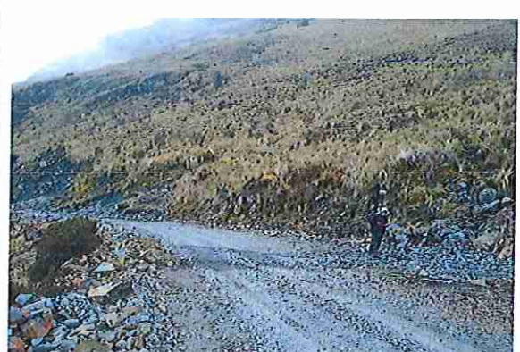
foto 36: KM 01 + 750 Terreno plano con un ancho de superficie 3.70 m.
