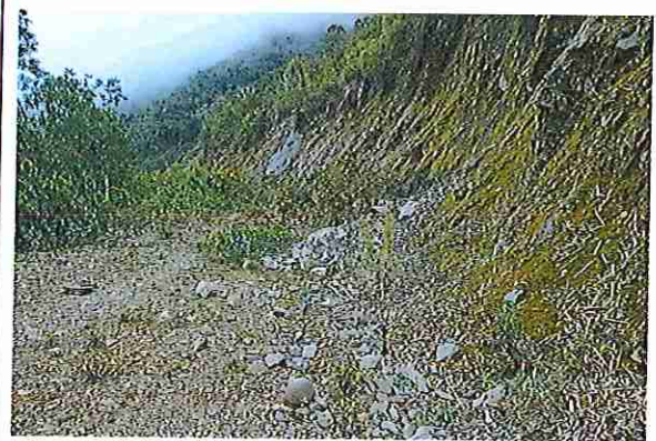
foto 122: KM 06 + 050, Ausencia de material de afirmado, con presencia de deformaciones y erosiones
