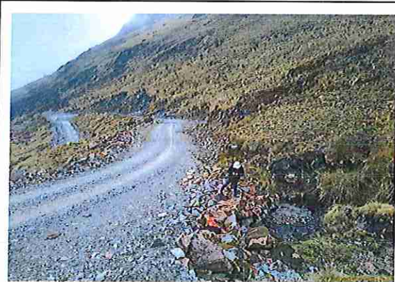
foto 22: KM 01 + 050, donde se puede observar que tiene la capa de rodadura tiene erosión.
