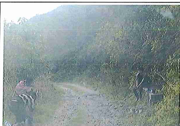
foto 353: KM 17 + 600 Terreno plano con un ancho de superficie de 4.03 m.
