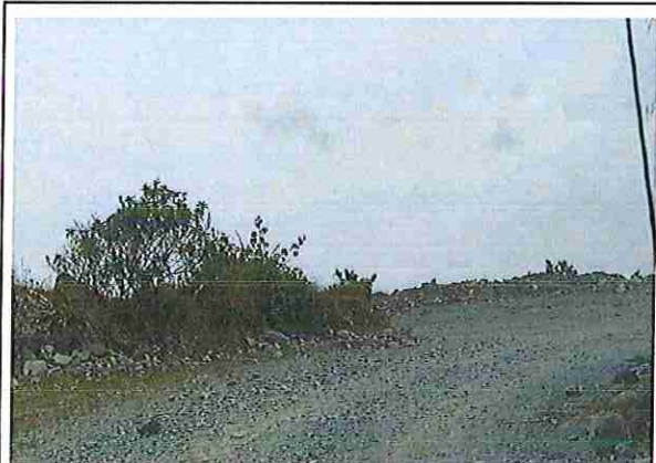
foto 171: KM 08 + 500 Terreno ondulado con un ancho de superficie 4.04 m.
