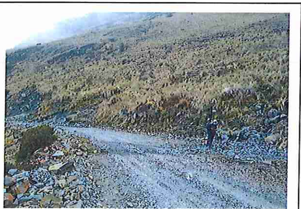
foto 47: KM 02 + 300 Terreno plano con un ancho de superficie de 4.08 m.
