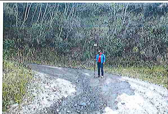
foto 191: KM 09 + 500 Terreno ondulado con un ancho de superficie 3.94 m.
