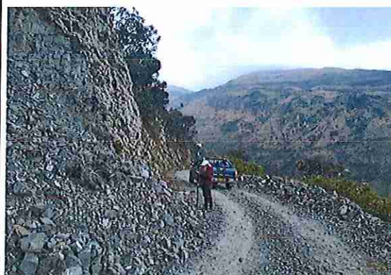
foto 192: KM 09 + 550 Terreno ondulado con un ancho de superficie 3.94 m.
