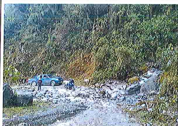
foto 05: KM 09 + 000 Fuente de agua lado derecho.
