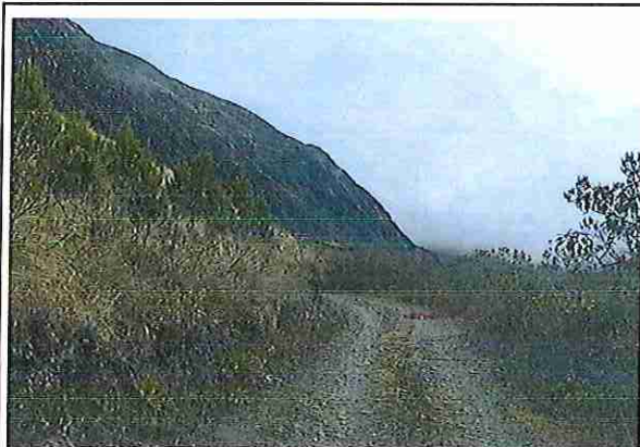
foto 15: KM 00 + 700 Terreno ondulado con un ancho de superficie 4.00 m.
