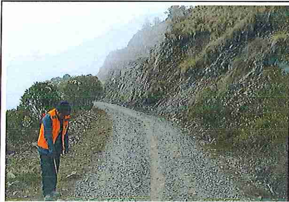
foto 153: KM 07 + 600 Terreno plano con un ancho de superficie 4.20 m.
