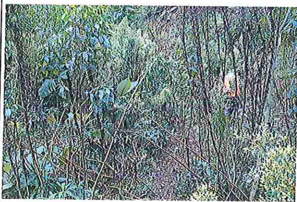
foto 129: KM 06 + 400, Ausencia de material de afirmado, con presencia de deformaciones y erosiones
