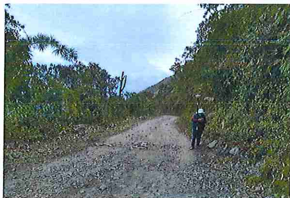
foto 203: KM 10 + 100 Terreno plano con un ancho de superficie de 4.08 m.
