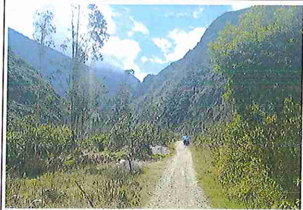
foto 88: KM 21 + 750, Ausencia de material de afirmado, con presencia de deformaciones y erosiones.
