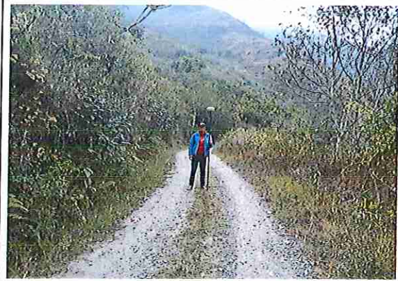
foto 406: KM 20 + 250 Terreno plano con un ancho de superficie de 4.03 m.
