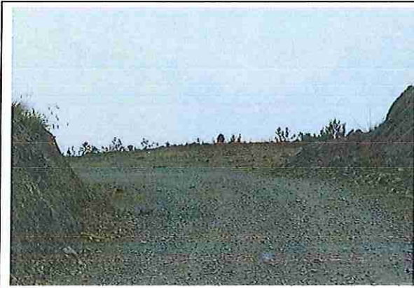
foto 139: KM 06 + 900 Terreno plano con un ancho de superficie de 4.08 m.
