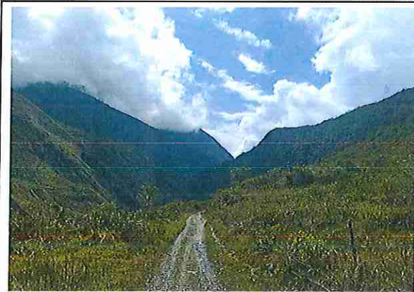
foto 421: KM 21 + 000 Terreno plano con un ancho de superficie de 4.03 m.
