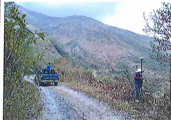
foto 222: KM 11 + 050, donde se puede observar que la capa de rodadura tiene baches y ausencia de material.
