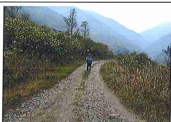
foto 234: KM 11 +650 Terreno accidentado con un ancho de superficie 4.00 m.
