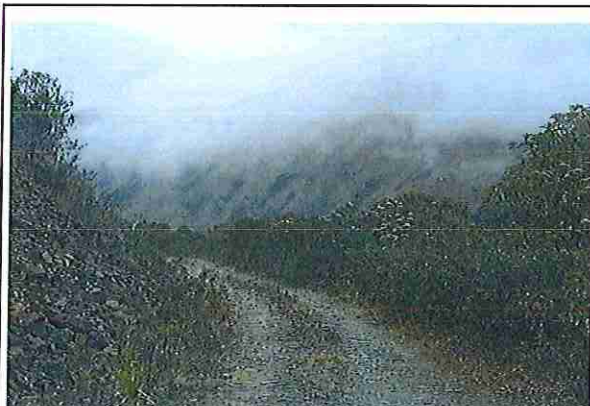
foto 12: KM 00 + 550 Terreno ondulado con un ancho de superficie 4.02 m.
