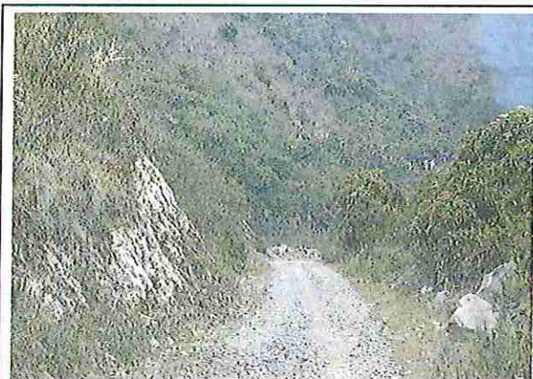
foto 57: KM 14 + 000, talud margen Izq. Ausencia de material de afirmado, con presencia de deformaciones y erosione.
