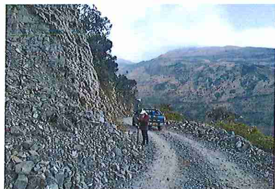
foto 143: KM 07 + 100 Terreno plano con un ancho de superficie 4.04 m.
