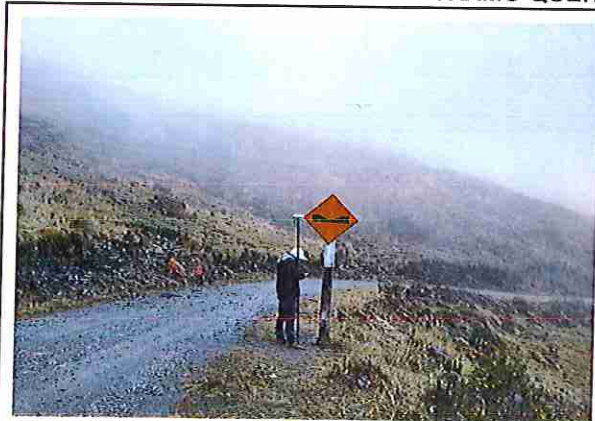
FOTO N°01: SEÑAL PREVENTIVA 02 + 030, estado regular. Falta pintura.
