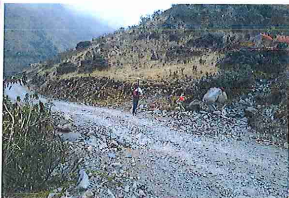
foto 23: KM 01 + 100 Terreno ondulado con un ancho de superficie 3.89 m.
