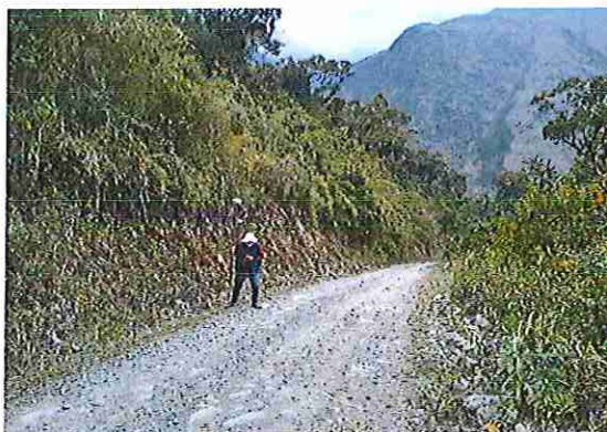
foto 286: KM 14 + 250 Terreno plano con un ancho de superficie de 4.05 m.
