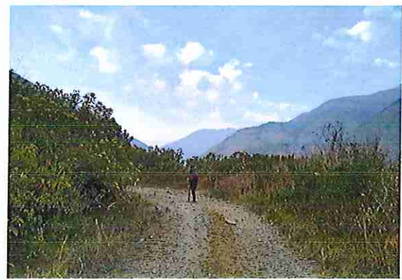
foto 292: KM 14 + 550 Terreno ondulado con un ancho de superficie de 3.98 m.
