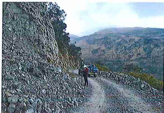
foto 187: KM 09 + 300 Terreno plano con un ancho de superficie de 4.08 m.
