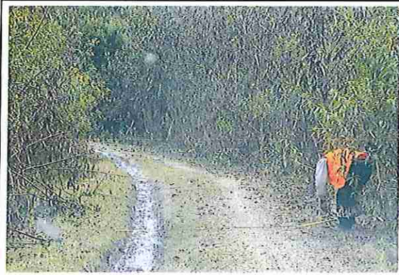
foto 55: KM 02 + 700 Terreno ondulado con un ancho de superficie 3.95 m.
