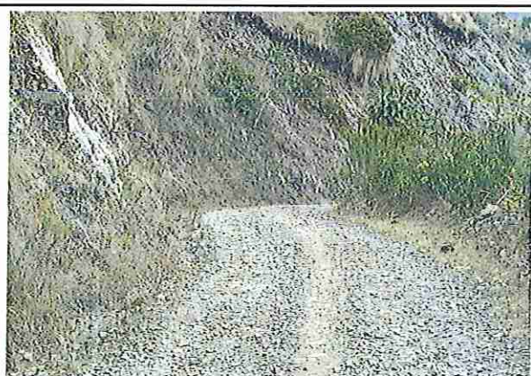
foto 233: KM 11 + 600 Terreno accidentado con un ancho de superficie 4.00 m.
