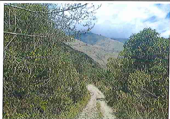
foto 369: KM 18 + 400 Terreno plano con un ondulado de superficie 3.98 m.
