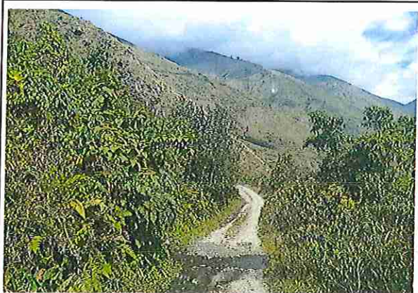
foto 435: KM 21 + 700 Terreno plano con un ancho de superficie de 4.03 m.
