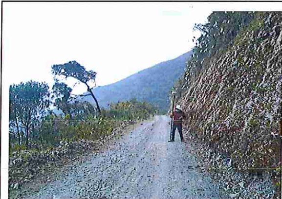
foto 147: KM 07 + 300 Terreno ondulado con un ancho de superficie 4.04 m.
