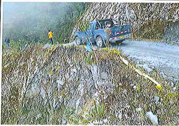
foto 39: KM 09 + 500 Talud margen Der.Ausencia de material de afirmado, con presencia de deformaciones y erosiones.
