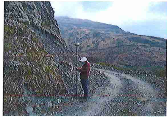
foto 278: KM 13 + 850, donde se puede observar que la capa de rodadura tiene baches y ausencia de material.
