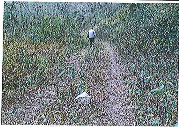
foto 105: KM 05 + 200, donde se puede observar que tiene la capa de rodadura tiene erosión
