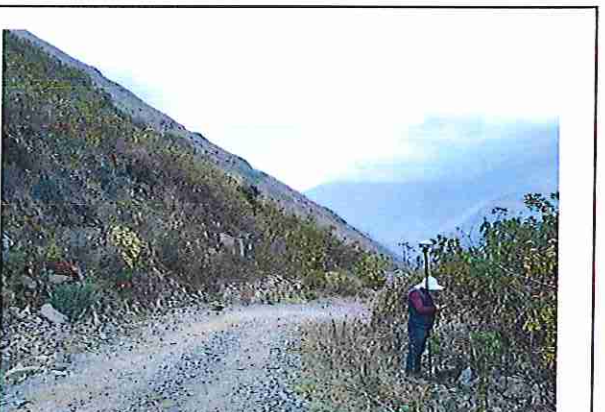
foto 216: KM 10 + 750 Terreno plano con un ancho de superficie de 4.08 m.
