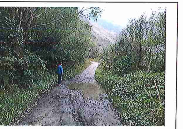
foto 264: KM 13 + 150 Terreno plano con un ancho de superficie de 4.03 m.
