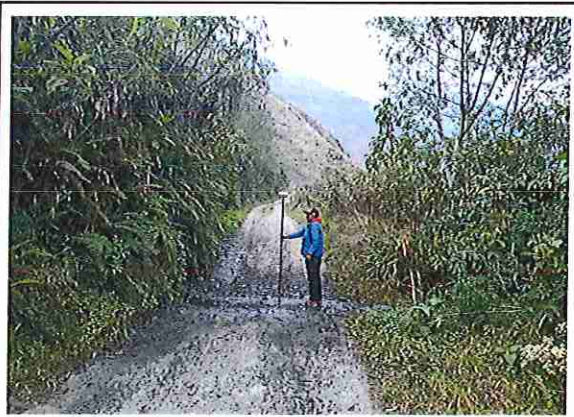
foto 414: KM 20 + 650 Terreno plano con un ondulado de superficie 4.04 m.
