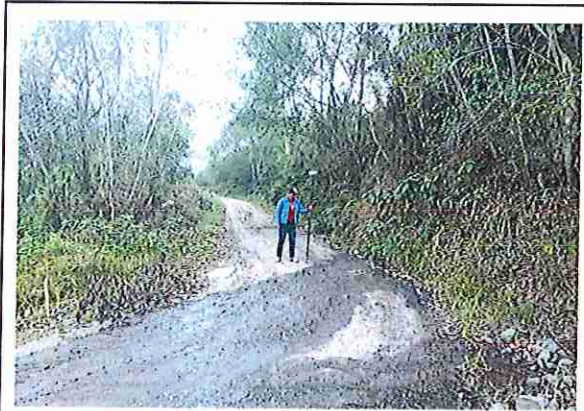
foto 247: KM 12 + 300 Terreno accidentado con un ancho de superficie 3.90 m.
