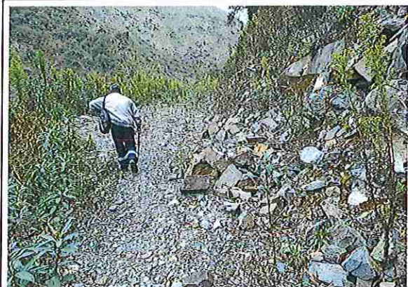
Foto 98: KM 04 + 850 Terreno ondulado con un ancho de superficie 4.01 m.
