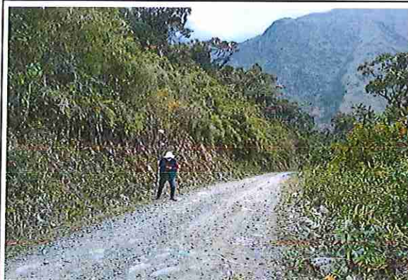
foto 254: KM 12 + 650 Terreno plano con un ancho de superficie de 4.01 m.
