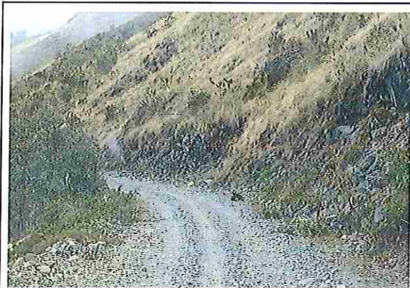
foto 157: KM 07 + 800 Terreno plano con un ancho de superficie 3.85 m.
