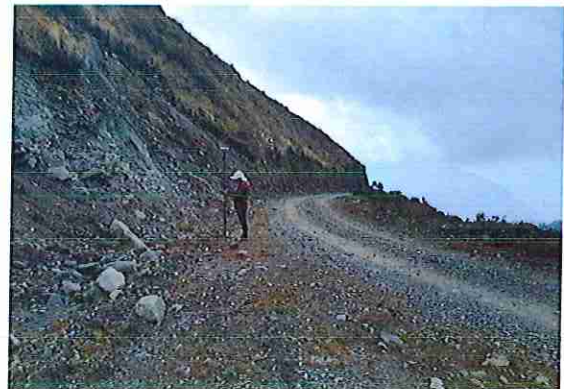
foto 34: KM 01 + 650 Terreno plano con un ancho de superficie 3.85 m.
