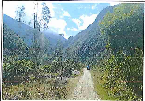
foto 434: KM 21 + 650 Terreno plano con un ancho de superficie de 4.03 m.
