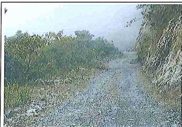
foto 179: KM 08 + 900 Terreno plano con un ancho de superficie de 4.08 m.
