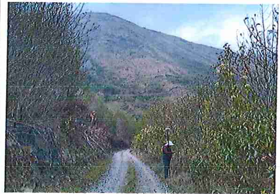
foto 322: KM 16 + 050, Ausencia de material de afirmado, con presencia de deformaciones y erosiones
