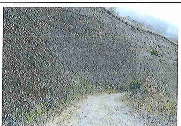
foto 48: KM 02 + 350 Terreno ondulado con un ancho de superficie 3.98 m.
