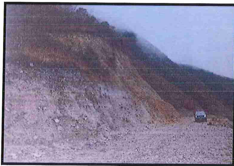
FOTO N° 04: Vista de la cantera C2 07 + 100km (320069.00 E - 8471793.00N) – TRAMO PUMACHACA-MAPURAYA
