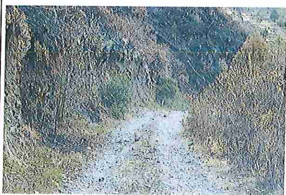
foto 23: KM 01 + 100 Terreno plano con un ancho de superficie 4.08 m.
