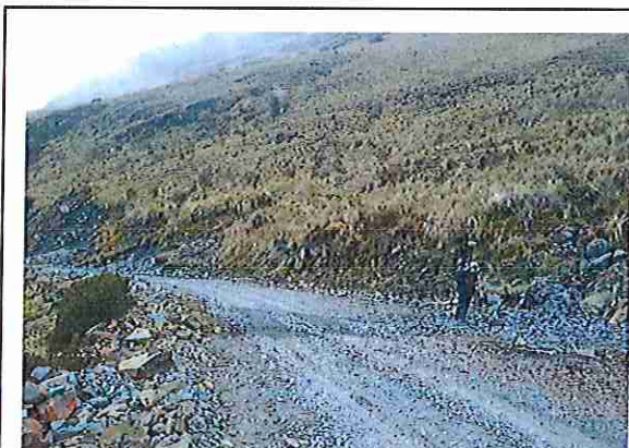
foto 127: KM 06 + 300 Terreno ondulado con un ancho de superficie 3.80 m.
