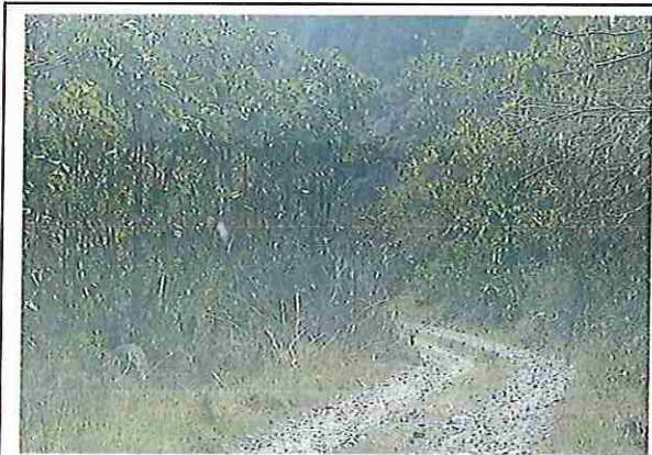
foto 349: KM 17 + 400 Terreno plano con un ancho de superficie de 4.03 m.
