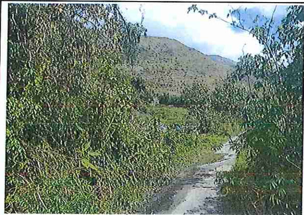
foto 433: KM 21 + 600 Terreno plano con un ancho de superficie de 4.01 m.
