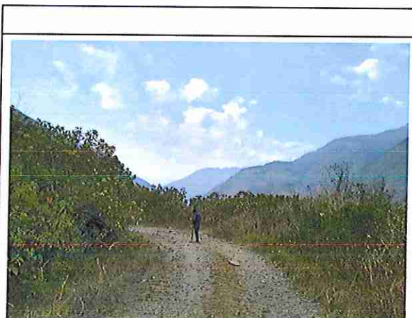
foto 68: KM 16 + 750, Ausencia de material de afirmado, con presencia de deformaciones y ahuellamiento.
