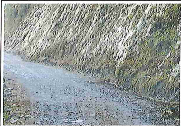
Foto 194: KM 09 + 650 Terreno plano con un ancho de superficie de 4.08 m.
