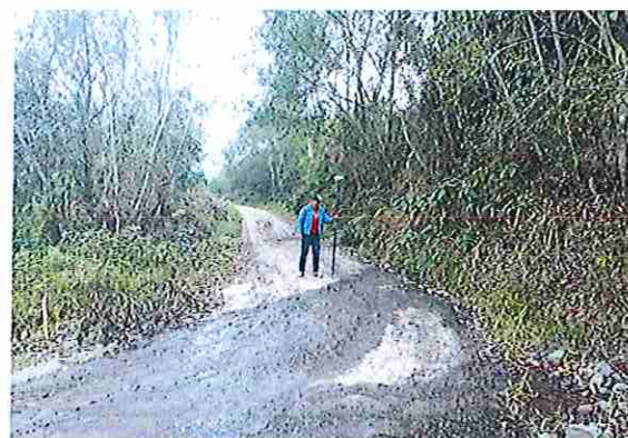
foto 314: KM 15 + 650 Terreno plano con un ancho de superficie de 4.01 m.
