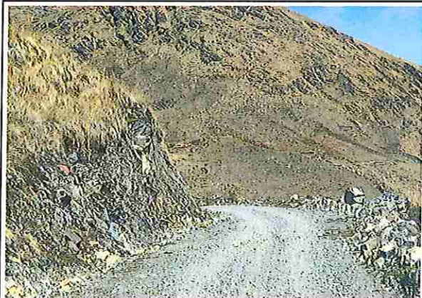
foto 03: KM 00 + 100 Terreno plano con un ancho de superficie 4.04 m.
