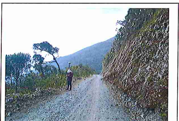
foto 276: KM 13 + 750 Terreno plano con un ancho de superficie de 4.05 m.
