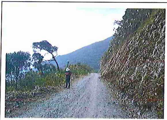
foto 146: KM 07 + 250 , Talud margen Der. Ausencia de material de afirmado, con presencia de deformaciones y erosiones.
