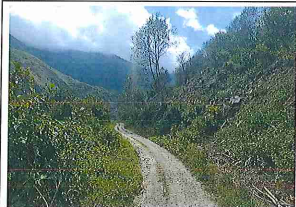
foto 409: KM 20 + 400 Terreno plano con un ondulado de superficie 4.04 m.
