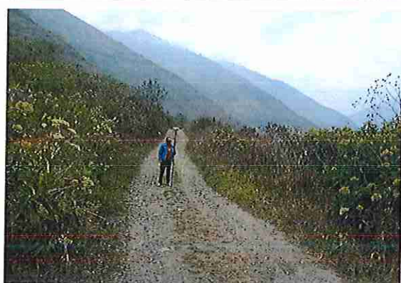
foto 319: KM 15 + 900 Terreno plano con un ancho de superficie de 4.03 m.
