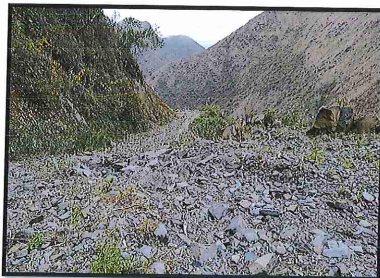
FOTO N° 08 Se puede apreciar el estado de la superficie de rodadura entre el Km 7 + 001- Km 7 + 924
