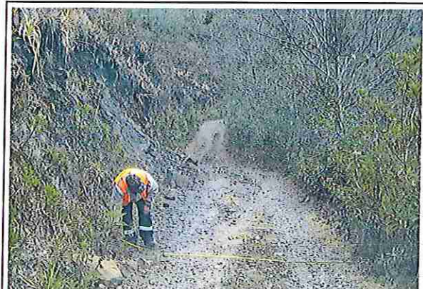
foto 04: KM 00 + 150 Terreno ondulado con un ancho de superficie 3.80 m.
