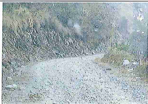
foto 177: KM 08 + 800 Terreno ondulado con un ancho de superficie 3.97 m.
