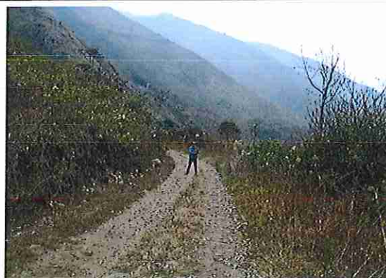
foto 288: KM 14 + 350 Terreno plano con un ancho de superficie de 4.08 m.
