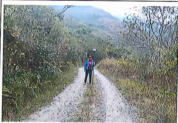
foto 235: KM 11 + 700, donde se puede observar que la capa de rodadura tiene baches y ausencia de material.
