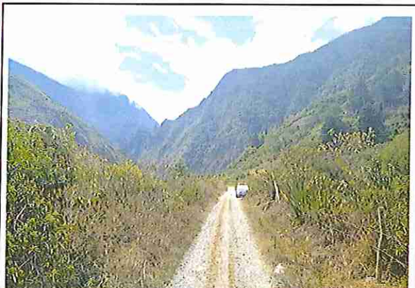
foto 447: KM 22 + 350 Terreno plano con un ancho de superficie de 4.04 m.
