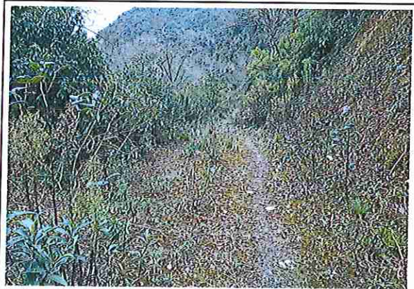
Foto 108: KM 05 + 350, donde se puede observar que tiene la capa de rodadura tiene erosión
