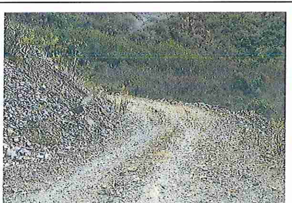
Foto 78: KM 03 + 850 Terreno plano con un ancho de superficie 3.98 m.
