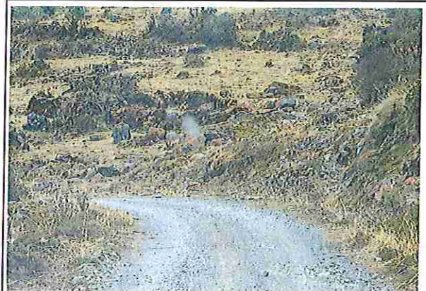
foto 166: KM 08 + 250 Terreno ondulado con un ancho de superficie 3.97 m.
