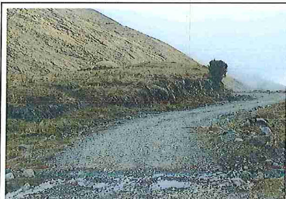
foto 85: KM 04 + 200 Terreno plano con un ancho de superficie 3.89 m.
