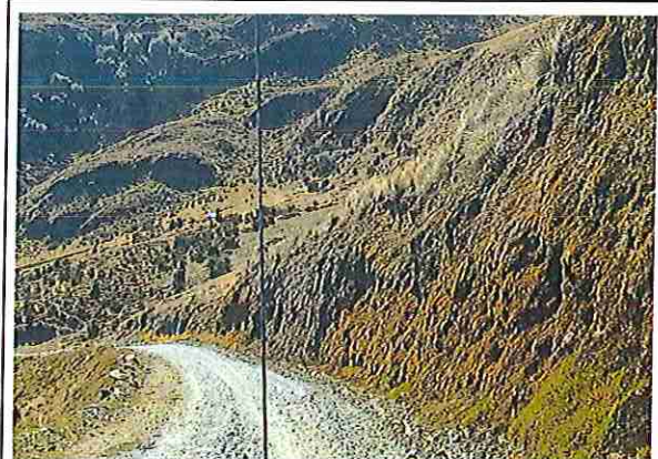
foto 48: 02 + 350, Ausencia de material de afirmado, con presencia de deformaciones y erosiones.
