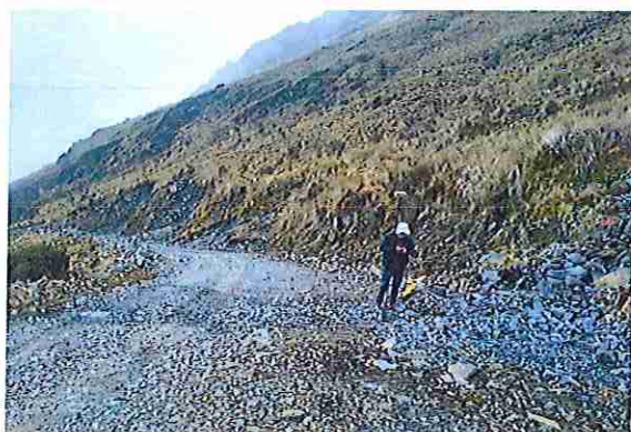
foto 95: KM 04 + 700 Terreno plano con un ancho de superficie 4.20 m.
