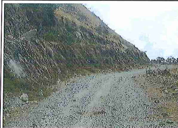
foto 130: KM 06 +450 Terreno plano con un ancho de superficie de 4.08 m.
