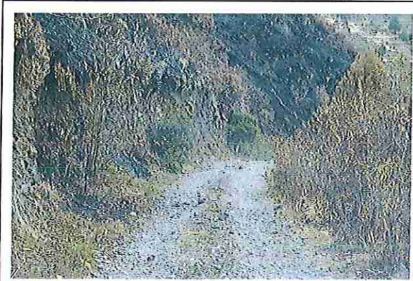
foto 07: KM 00 + 300, Ausencia de material de afirmado, con presencia de deformaciones y erosiones.
