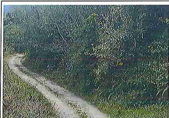
foto 325: KM 16 + 200 Terreno plano con un ancho de superficie de 4.03 m.
