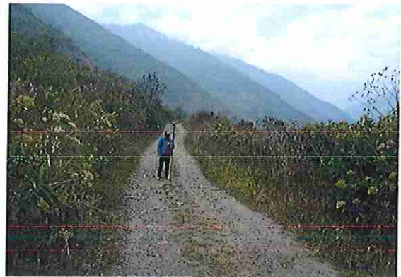
foto 380: KM 18 + 950, Ausencia de material de afirmado, con presencia de deformaciones y erosiones.
