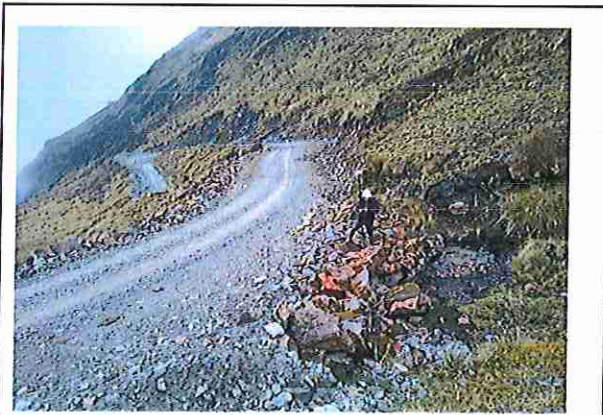
foto 126: KM 06 + 250, Ausencia de material de afirmado, con presencia de deformaciones y erosiones.
