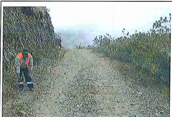
foto 011: KM 00 + 500 Terreno ondulado con un ancho de superficie 4.00 m.
