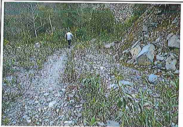
Foto 94: KM 04 + 650, donde se puede observar que tiene la capa de rodadura tiene erosión
