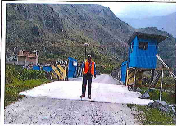
foto 01: KM 0+010; Puente Pumachaca.
