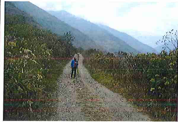
foto 410: KM 20 + 450 Terreno plano con un ancho de superficie de 4.03 m.
