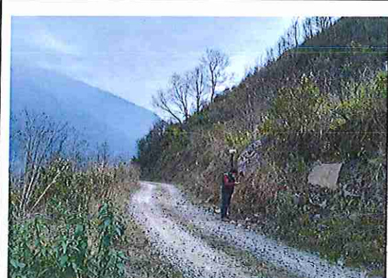
foto 396: KM 19 + 750 Terreno plano con un ancho de superficie de 4.08 m.
