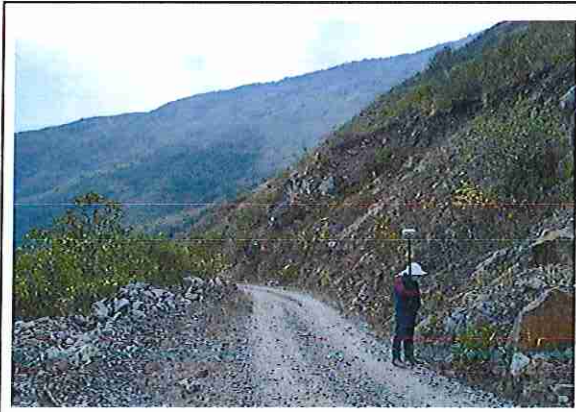
foto 332: KM 16 + 550 Terreno plano con un ondulado de superficie 3.97 m.
