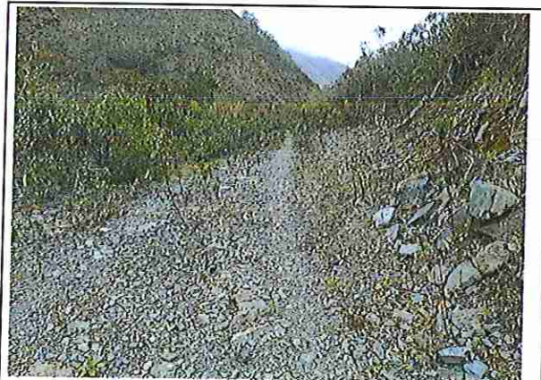
Foto 18: KM 04 + 250, donde se puede observar que tiene la capa de rodadura tiene erosión
