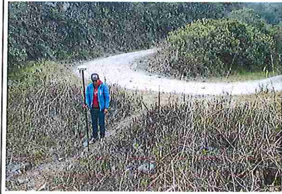
foto 374: KM 18 + 650 Terreno plano con un ancho de superficie de 4.03 m.
