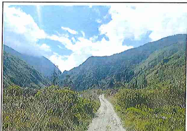
foto 437: KM 21 + 800 Terreno plano con un ancho de superficie 3.89 m.
