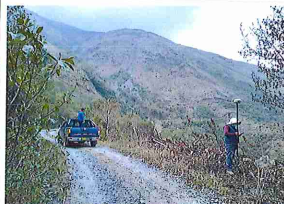
foto 222: KM 11 + 050 Terreno plano con un ancho de superficie de 4.08 m.
