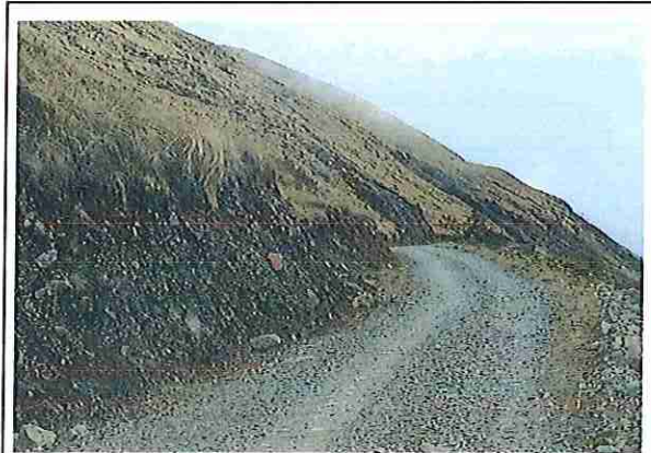
foto 98: KM 04 + 850 Terreno plano con un ancho de superficie de 4.08 m.
