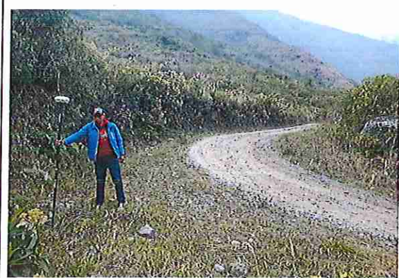
foto 232: KM 11 + 550 Terreno plano con un ancho de superficie de 4.01 m.
