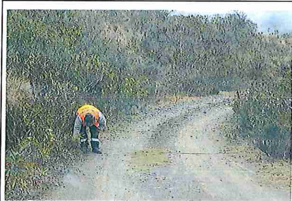
foto 13: KM 00 + 600 Terreno ondulado con un ancho de superficie 4.00 m.
