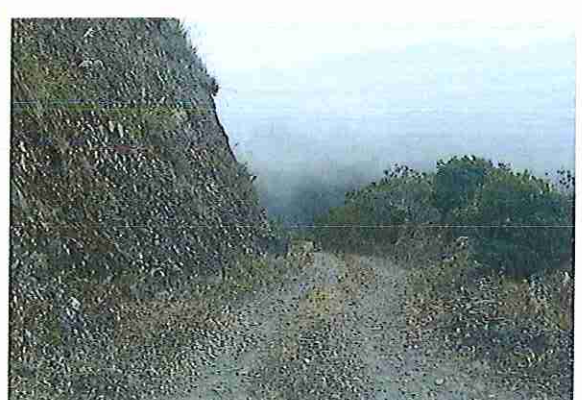
foto 71: KM 03 + 500 Terreno plano con un ancho de superficie 3.99 m.
