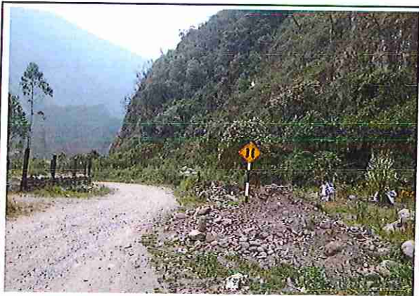
FOTO N° 03: SEÑAL PREVENTIVA KM 11 + 610, estado regular. Falta pintura
