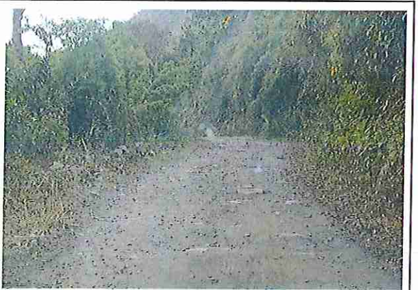
foto 261: KM 13 + 000 Terreno plano con un ancho de superficie de 4.02 m.
