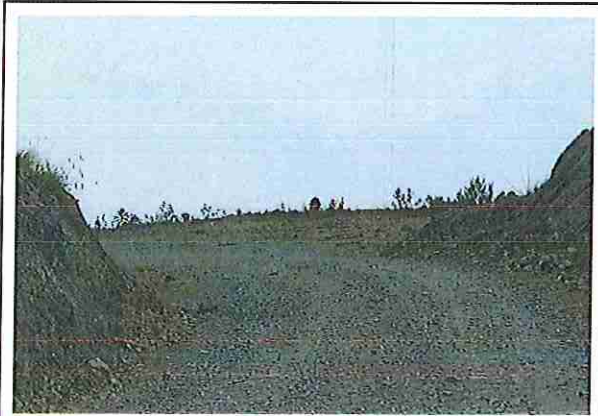
foto 133: KM 06 + 600 Terreno plano con un ancho de superficie 4.04 m.
