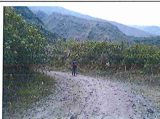
foto 304: KM 15+ 150 Terreno ondulado con un ancho de superficie de 3.97 m.
