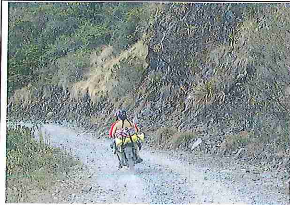
foto 181: KM 09 + 000, Ausencia de material de afirmado, con presencia de deformaciones y erosiones.
