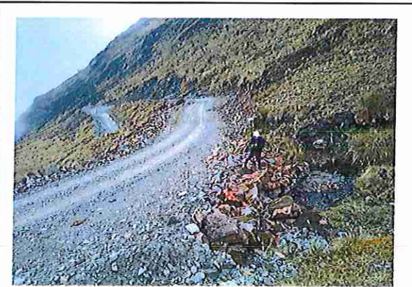
foto 46: 02 + 250 Terreno ondulado con un ancho de superficie 3.88 m.
