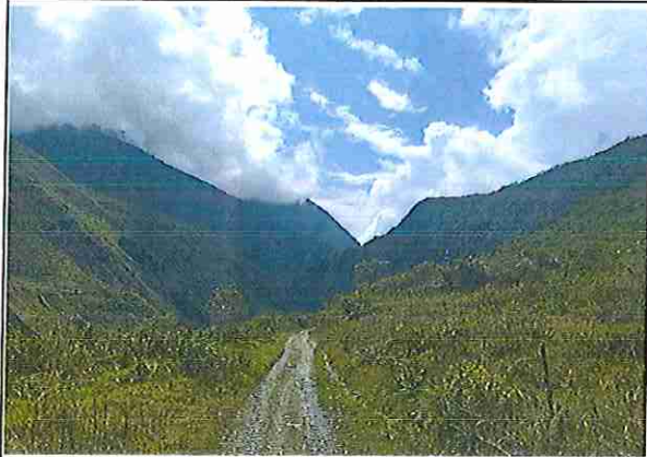
foto 87: KM 21 + 500, Ausencia de material de afirmado, con presencia de deformaciones y erosiones.
