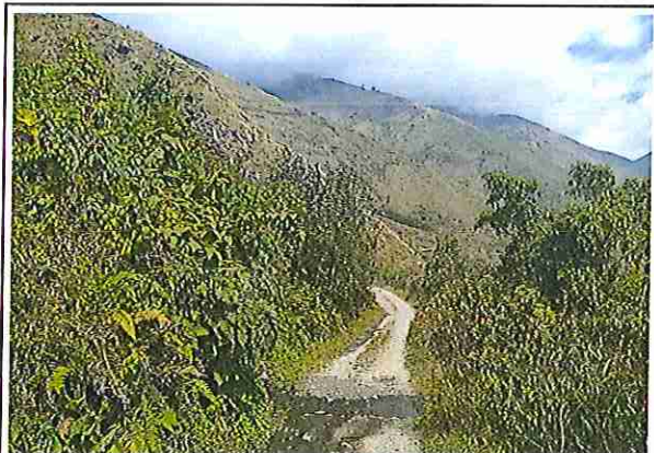
foto 448: KM 22 + 400 Terreno plano con un ancho de superficie de 4.03 m.
