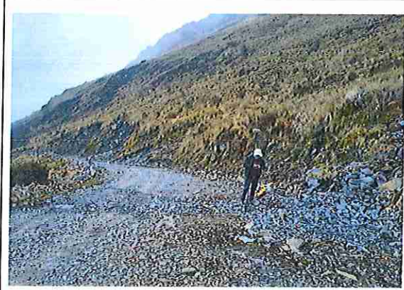
foto 54: KM 02 + 650, Ausencia de material de afirmado, con presencia de deformaciones y erosiones.
