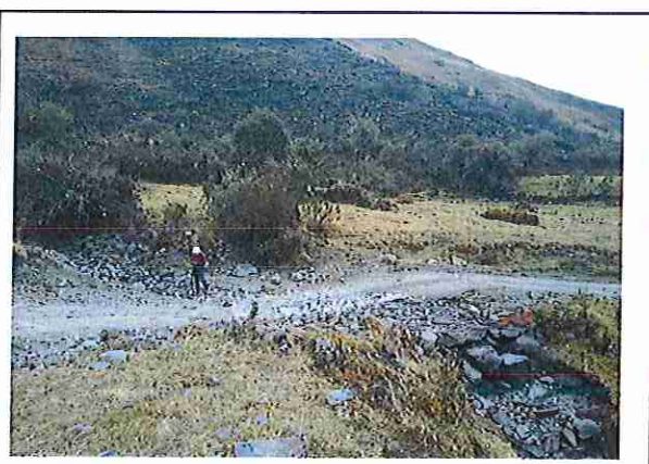
foto 38: KM 01 + 850 Terreno accidentado con un ancho de superficie 3.83
