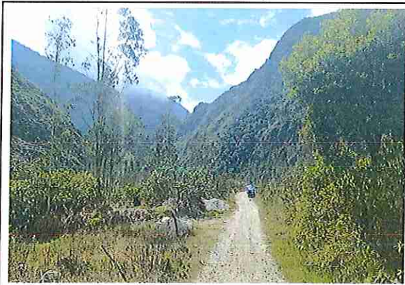
foto 450: KM 22 + 500 Terreno plano con un ancho de superficie de 4.02 m.
