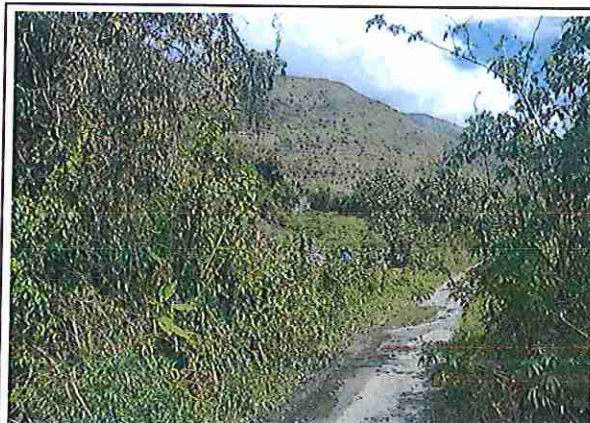
foto 422: KM 21 + 050, Ausencia de material de afirmado, con presencia de deformaciones y erosiones.
