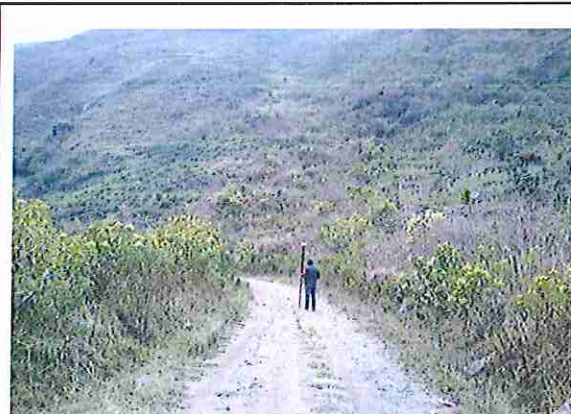
foto 306: KM 15 + 250 Terreno ondulado con un ancho de superficie de 3.94 m.
