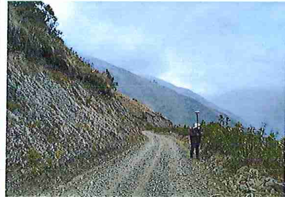
foto 208: KM 10 + 350 Terreno ondulado con un ancho de superficie 3.96 m.
