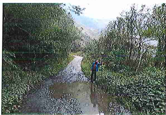
foto 363: KM 18 + 100 Terreno plano con un ancho de superficie de 4.03 m.
