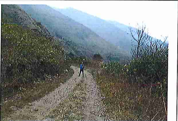
foto 371: KM 18 + 500 Terreno plano con un ancho de superficie 3.89 m.
