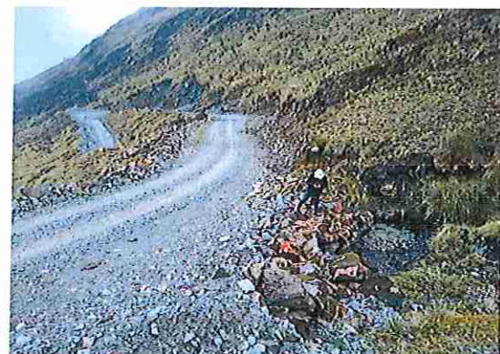
foto 92: KM 04 + 550 Terreno plano con un ancho de superficie de 4.08 m.
