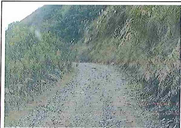
foto 229: KM 11 + 400 Terreno accidentado con un ancho de superficie 4.00 m.
