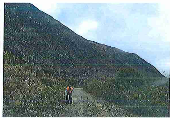
foto 28: KM 01 + 350 Terreno plano con un ancho de superficie 4.03 m.
