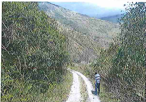
foto 389: KM 19 + 400 Terreno plano con un ancho de superficie de 4.03 m.
