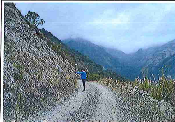
foto 156: KM 07 + 750 Terreno accidentado con un ancho de superficie 3.56 m.
