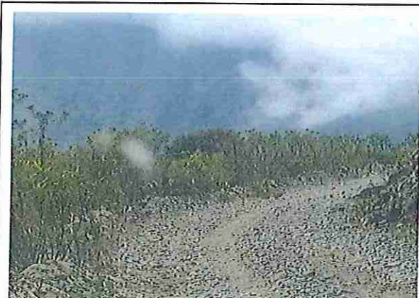
foto 317: KM 15 + 800, Ausencia de material de afirmado, con presencia de deformaciones y erosiones
