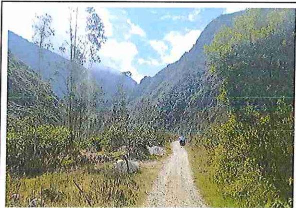
foto 446: KM 22 + 300 Terreno plano con un ancho de superficie de 4.03 m.
