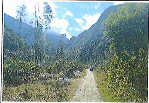
foto 434: KM 21 + 650, Ausencia de material de afirmado, con presencia de deformaciones y erosiones.
