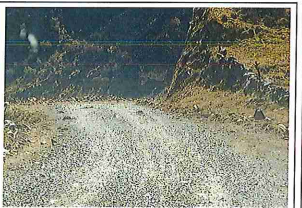
foto 41: KM 02 + 000 Terreno plano con un ancho de superficie 4.20 m.
