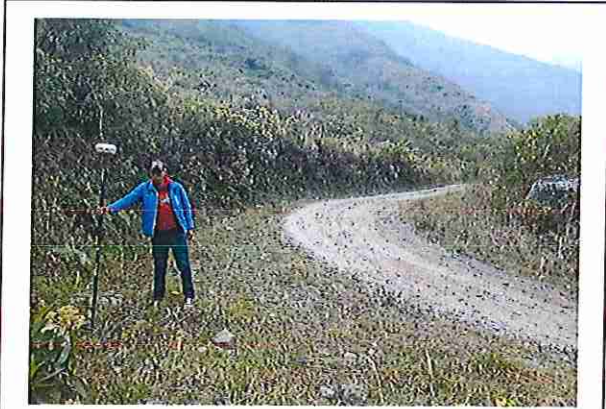
foto 259: KM 12 + 900 Terreno plano con un ancho de superficie de 4.08 m.
