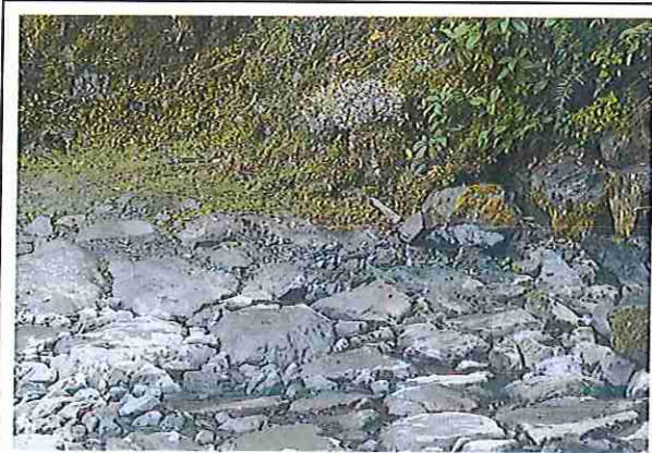
foto 205: KM 10 + 200, donde se puede observar que la capa de rodadura tiene baches y ausencia de material.
