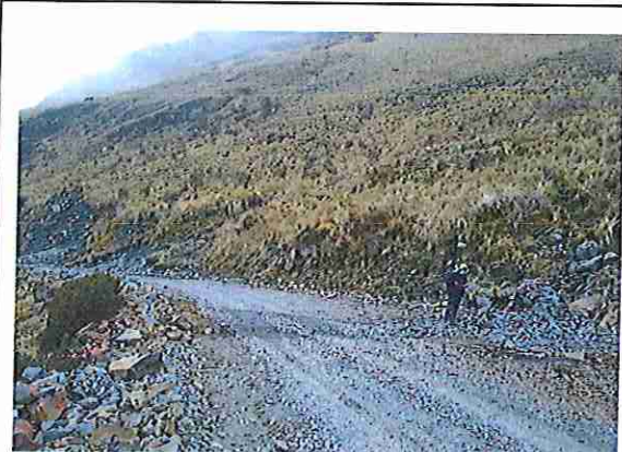
foto 66: KM 03 + 250,Ausencia de material de afirmado, con presencia de deformaciones y erosiones.
