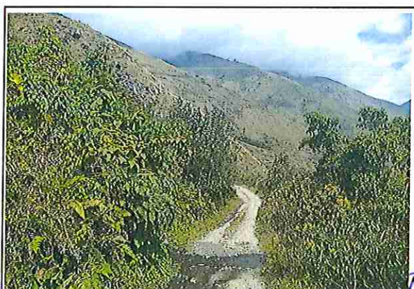
foto 431: KM 21 + 500 Terreno plano con un ancho de superficie 3.89 m.
