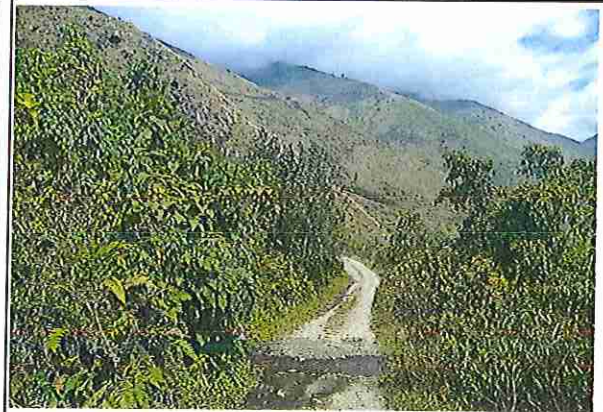
foto 440: KM 21 + 950 Terreno plano con un ancho de superficie de 4.01 m.
