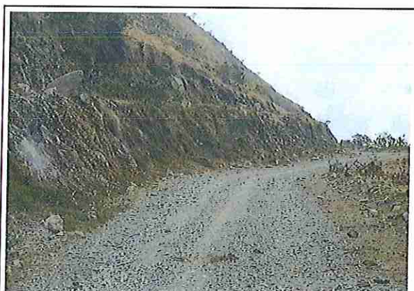
foto 114: KM 05 + 650, Talud margen izq. Ausencia de material de afirmado, con presencia de deformaciones y erosiones.
