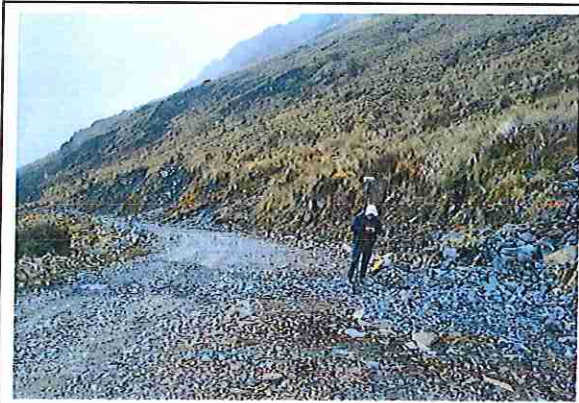
foto 67: KM 03 + 300 Terreno plano con un ancho de superficie de 4.08 m.
