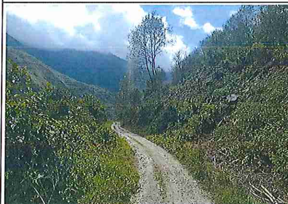
foto 420 KM 20 + 950 Terreno plano con un ancho de superficie 4.04 m.
