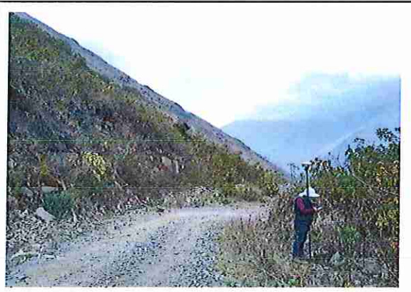
foto 334: KM 16 + 650 Terreno plano con un ancho de superficie de 4.03 m.
