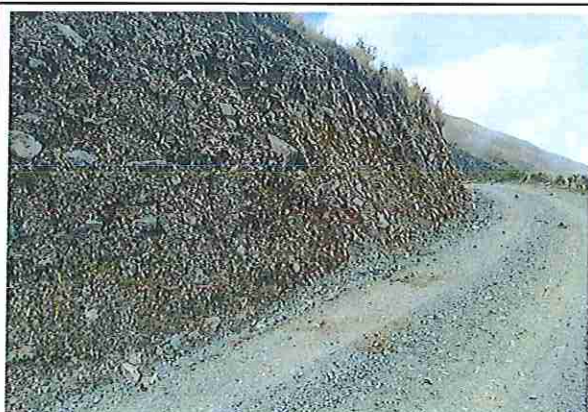
foto 24: KM 05 + 750, Talud margen izq. Ausencia de material de afirmado, con presencia de deformaciones y erosiones.
