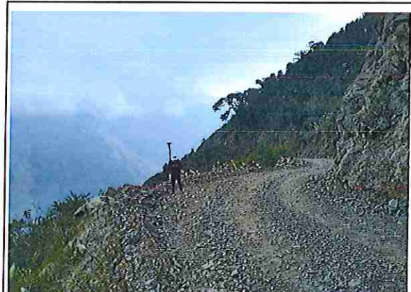
foto 168: KM 08 + 350 Terreno ondulado con un ancho de superficie 3.80 m.
