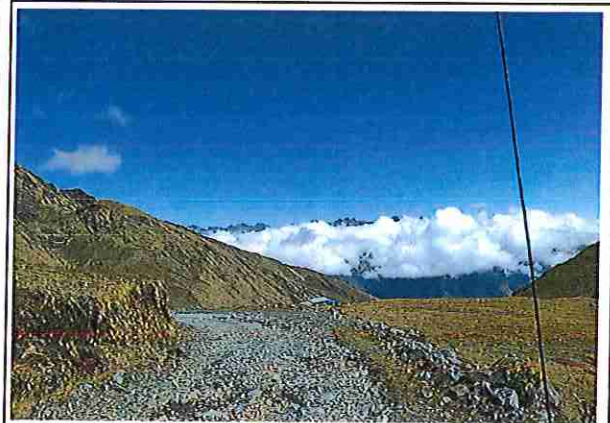
foto 20: KM 00 + 950 Terreno accidentado con un ancho de superficie 4.08 m.
