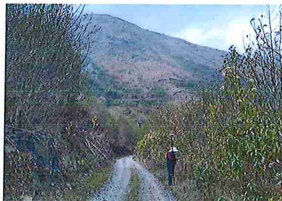
foto 322: KM 16 + 050 Terreno plano con un ancho de superficie de 4.05 m.
