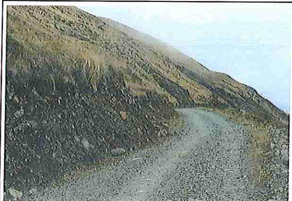
foto 102: KM 05 + 050, Ausencia de material de afirmado, con presencia de deformaciones y erosiones.
