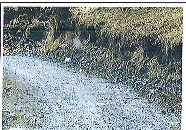
foto 18: KM 00 + 850 Terreno plano con un ancho de superficie 4.20 m.
