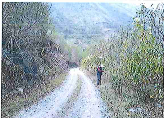
foto 323: KM 16 + 100 Terreno plano con un ancho de superficie de 4.03 m.
