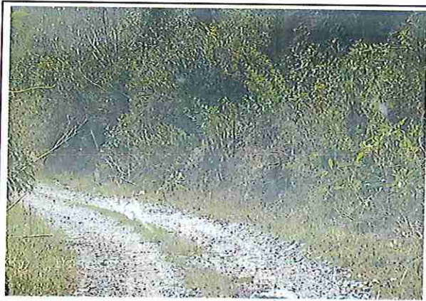
foto 313: KM 15 + 600, Ausencia de material de afirmado, con presencia de deformaciones y erosione
