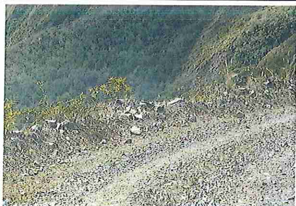
foto 297: KM 14 + 800, Ausencia de material de afirmado, con presencia de deformaciones y ahuellamiento.
