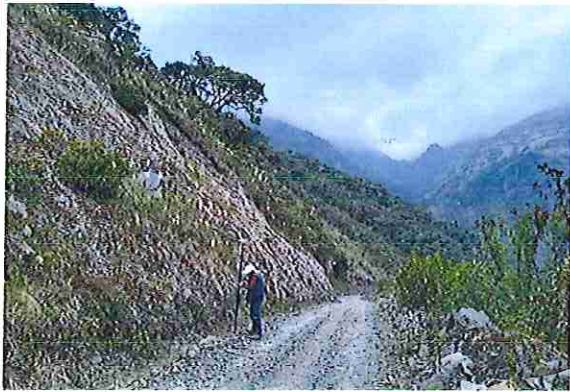
foto 207: KM 10 + 300 Terreno ondulado con un ancho de superficie 3.97 m.
