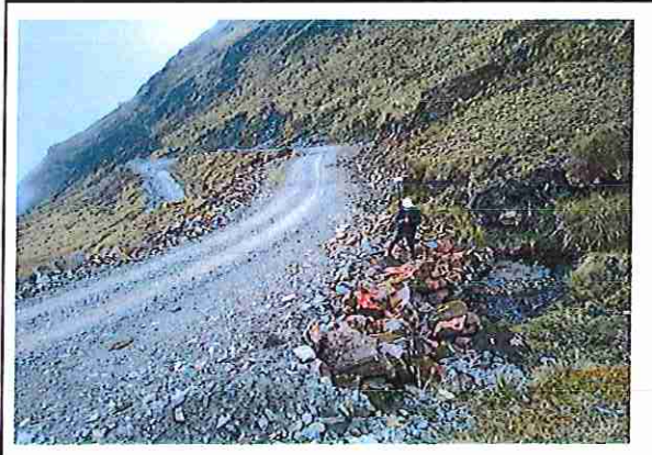
foto 100: KM 04 + 950 Terreno ondulado con un ancho de superficie 3.88 m.
