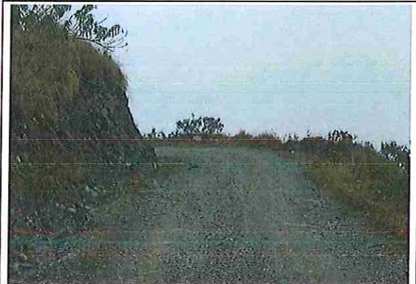
foto 176: KM 08 + 750 Terreno plano con un ancho de superficie 4.20 m.
