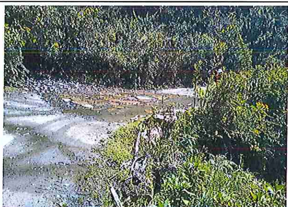
foto 11: baden KM 02 + 990, se encuentra en buen estado y parcialmente obstruida.
