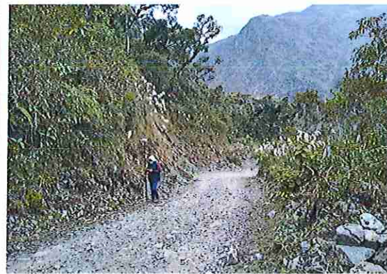
foto 228: KM 11 + 350 Terreno accidentado con un ancho de superficie 4.00 m.
