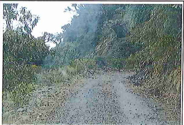
foto 213: KM 10 + 600 Terreno ondulado con un ancho de superficie 3.97 m.
