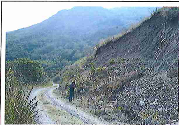
foto 399: KM 19 + 900, Ausencia de material de afirmado, con presencia de deformaciones y ahuellamiento.
