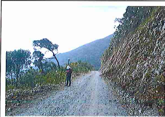
foto 151: KM 07 + 500 Terreno plano con un ancho de superficie 4.04 m.
