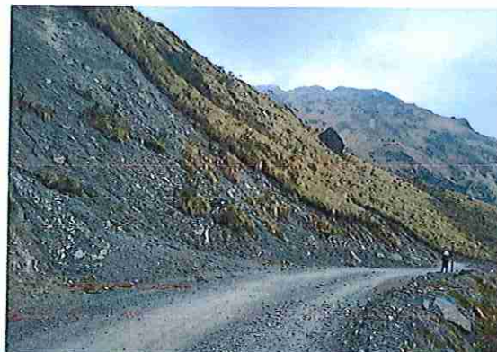
foto 74: KM 03 + 650 Terreno ondulado con un ancho de superficie 4.04 m.
