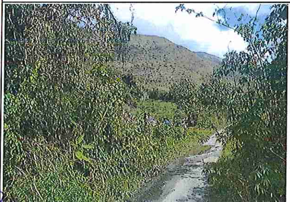
foto 426: KM 21 + 250 Terreno plano con un ancho de superficie de 4.03 m.
