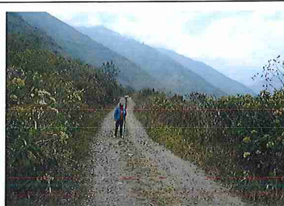
foto 338: KM 16 + 850, Ausencia de material de afirmado, con presencia de deformaciones y ahuellamiento.
