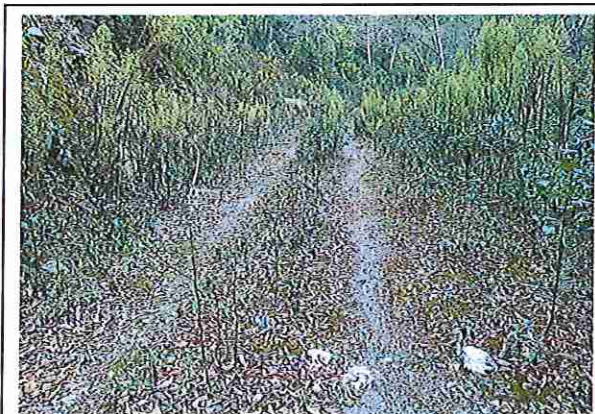
foto 103: KM 05 + 100 Terreno plano con un ancho de superficie 4.02 m.
