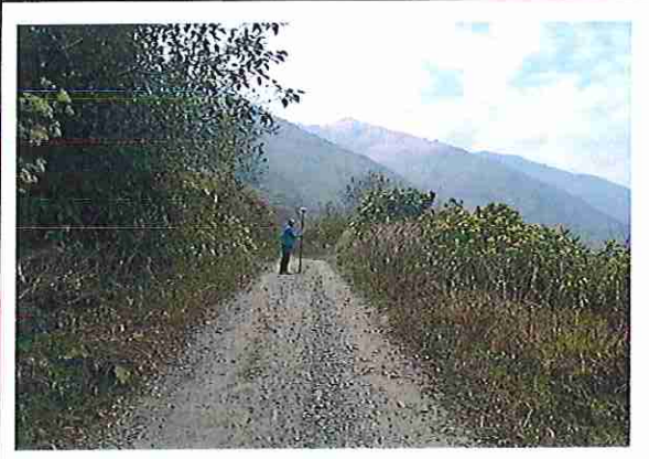
foto 360: KM 17 + 950, Ausencia de material de afirmado, con presencia de deformaciones y erosiones.
