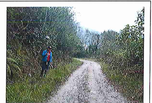
foto 311: KM 15 + 500 Terreno plano con un ancho de superficie de 4.08 m.
