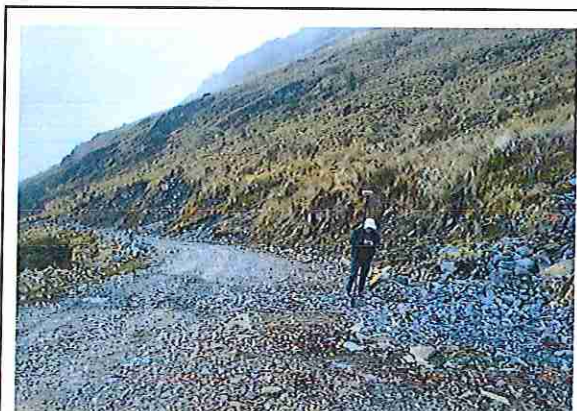
foto 55: KM 02 + 700 Terreno plano con un ancho de superficie 4.20 m.
