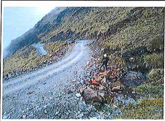
foto 126: KM 06 + 250 Terreno plano con un ancho de superficie de 4.08 m.
