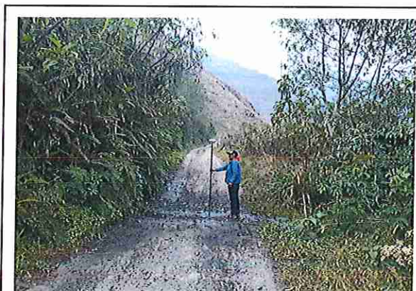
foto 439: KM 21 + 900, Ausencia de material de afirmado, con presencia de deformaciones y erosiones.
