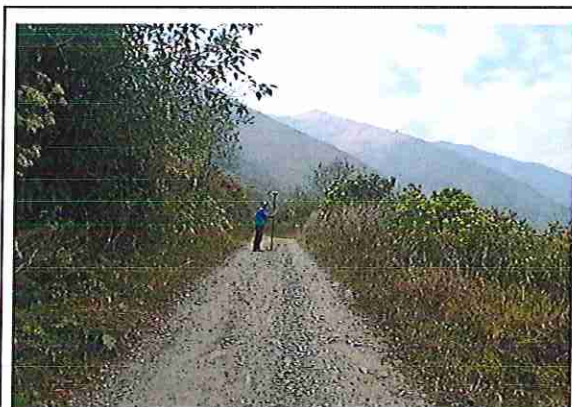
foto 418: KM 20 + 850 Terreno plano con un ondulado de superficie 4.04 m.
