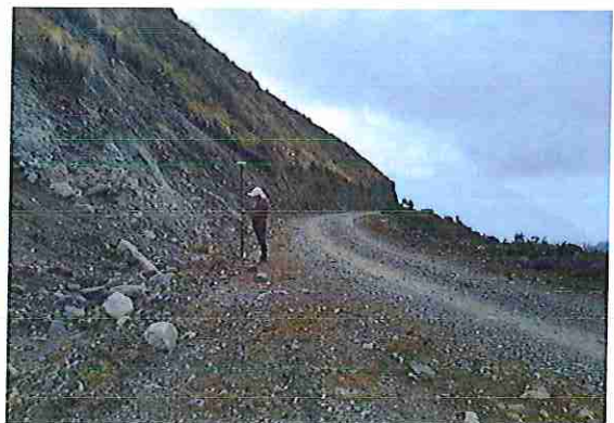
foto 34: KM 01 + 650, donde se puede observar que tiene la capa de rodadura tiene erosión severa.
