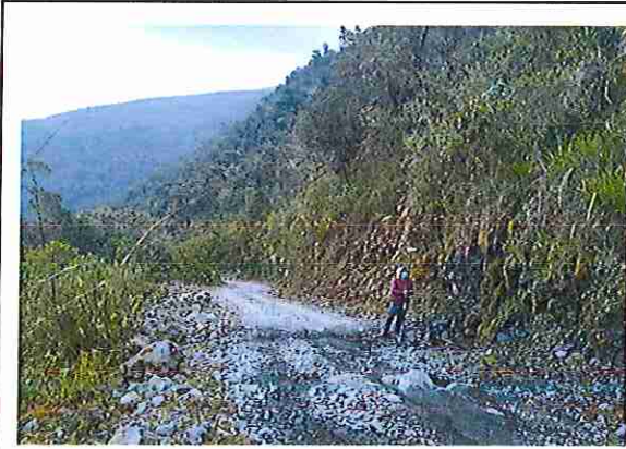
foto 199: KM 09 + 900 Terreno ondulado con un ancho de superficie 3.94 m.
