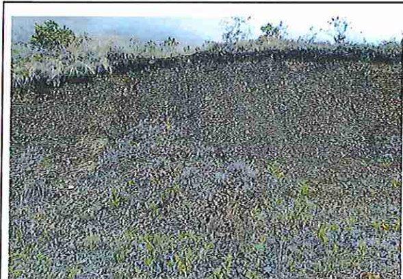
foto 64: KM 03 + 150, Ausencia de material de afirmado, con presencia de deformaciones y erosiones.
