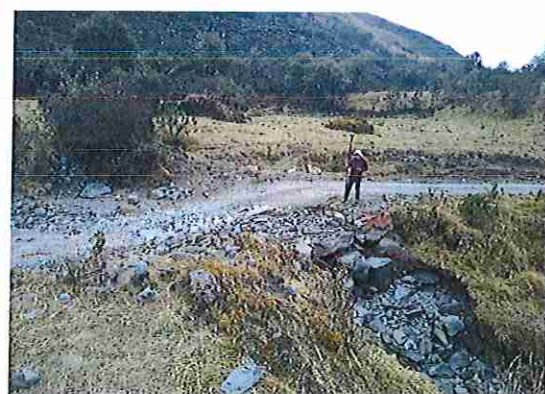
foto 24: KM 01 + 150 Terreno ondulado con un ancho de superficie 3.89 m.
