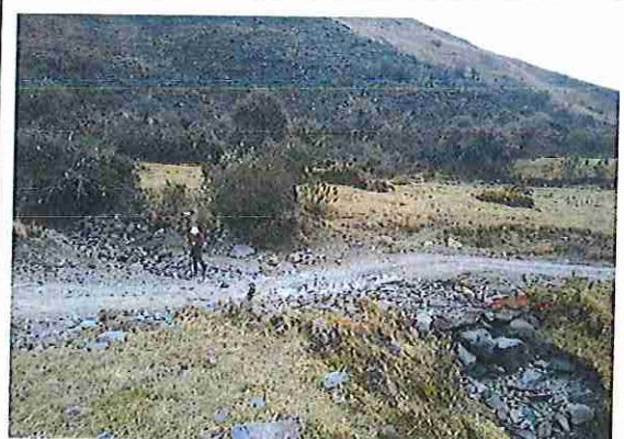
foto 60: KM 02 + 950,baden de piedra donde se puede observar que la capa de rodadura presenta ahuellamiento
