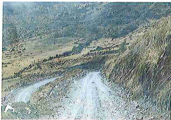
foto 69: KM 03 + 400 Terreno plano con un ancho de superficie 4.20 m.
