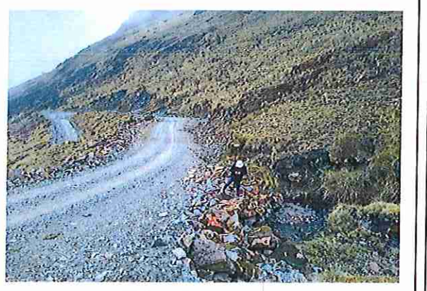
foto 119: KM 05 + 900 Terreno plano con un ancho de superficie de 4.08 m.
