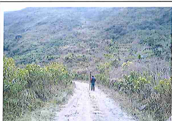
foto 303: KM 15 + 100 Terreno ondulado con un ancho de superficie de 3.99 m.
