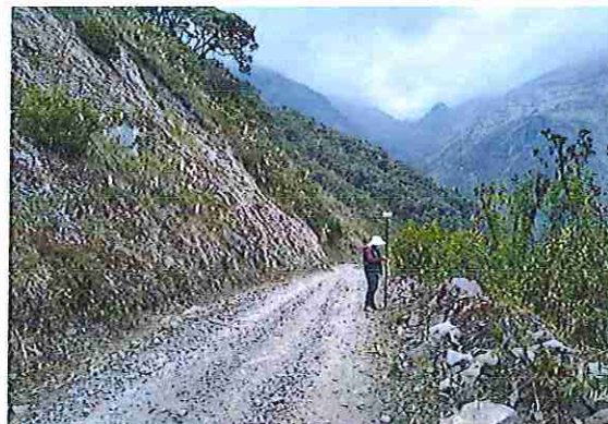
foto 328: KM 16 + 350 Terreno plano con un ancho de superficie de 4.01 m.
