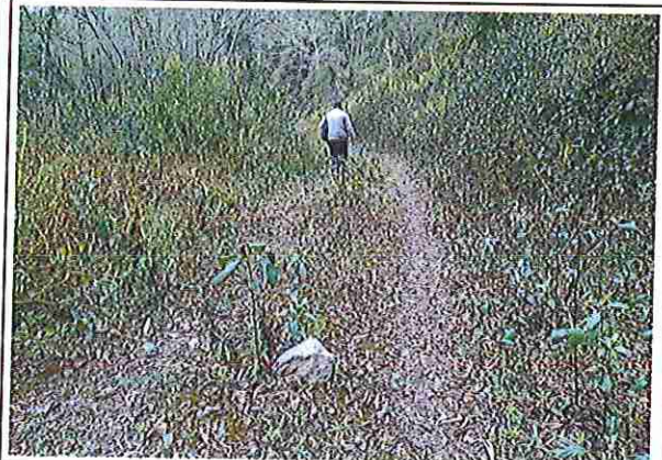
Foto 20: KM 04 + 750, donde se puede observar que tiene la capa de rodadura tiene erosión
