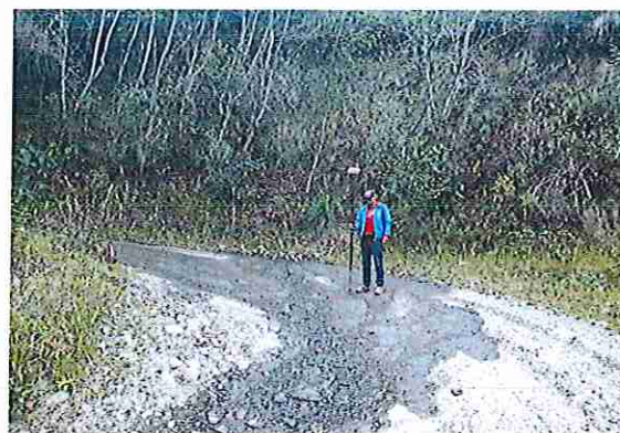
foto 190: KM 09 + 450 Terreno ondulado con un ancho de superficie 3.97 m.
