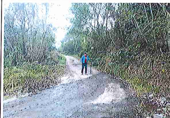
foto 244: KM 12 + 150 Terreno plano con un ancho de superficie de 4.01 m.
