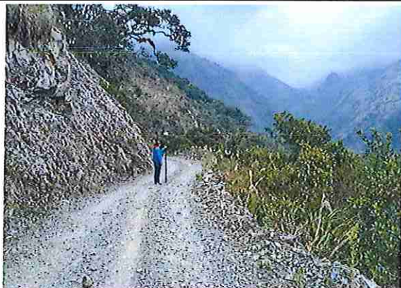
foto 155: KM 07 + 700 Terreno accidentado con un ancho de superficie 3.56 m.
