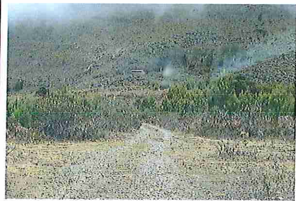
Foto 80: KM 03 + 950, donde se puede observar que tiene la capa de rodadura tiene erosión
