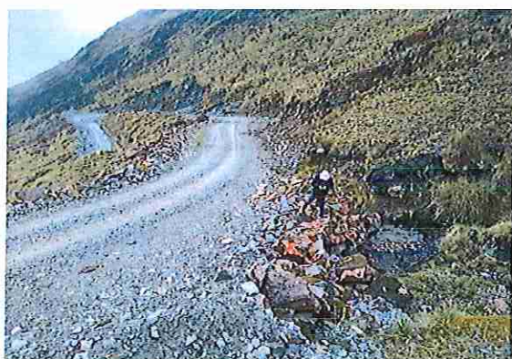
foto 87: KM 04 + 300 Terreno plano con un ancho de superficie 4.04 m.
