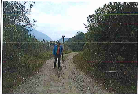
foto 390: KM 19 + 450 Terreno plano con un ondulado de superficie 4.04 m.
