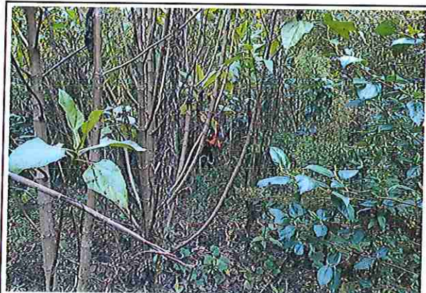
foto 150: KM 07 + 450, Ausencia de material de afirmado, con presencia de deformaciones y erosiones
