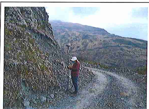
foto 150: KM 07 + 450 , Talud margen Der. Ausencia de material de afirmado, con presencia de deformaciones y erosiones.
