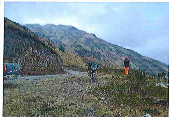
foto 70: KM 03 + 450 Terreno ondulado con un ancho de superficie 3.88 m.
