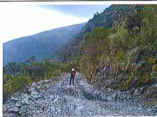
foto 268: KM 13 + 350 Terreno accidentado con un ancho de superficie de 3.98 m.
