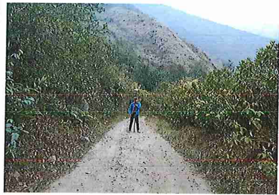
foto 236: KM 11 + 750 Terreno plano con un ancho de superficie de 4.08 m.
