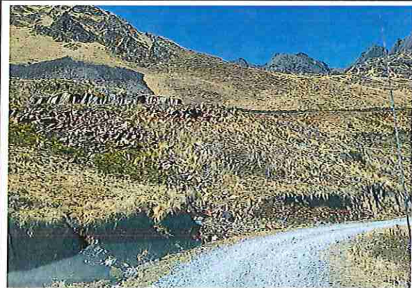
foto 01: KM 00 + 000 Terreno plano con un ancho de superficie 4.20 m.
