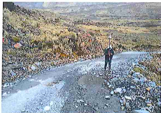
foto 30: KM 01 + 450, donde se puede observar que tiene la capa de rodadura tiene erosión.
