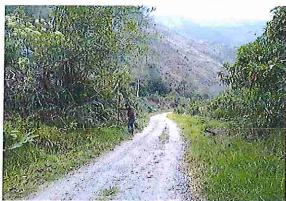
foto 375: KM 18 + 700 Terreno plano con un ondulado de superficie 4.04 m.
