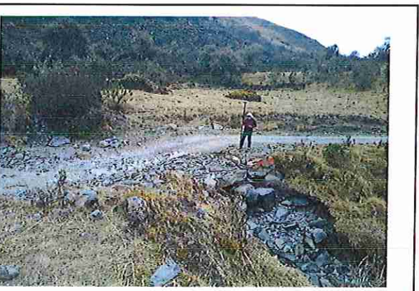
foto 40: KM 01 + 950 Terreno plano con un ancho de superficie 3.77 m.
