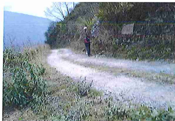
foto 324: KM 16 + 150 Terreno plano con un ancho de superficie de 4.05 m.
