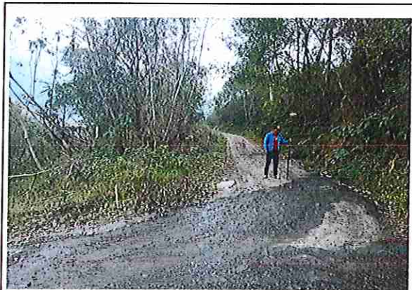
foto 368: KM 18 + 350 Terreno plano con un ancho de superficie de 4.08 m.
