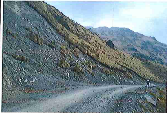
foto 91: KM 04 + 500 Terreno plano con un ancho de superficie 3.89 m.
