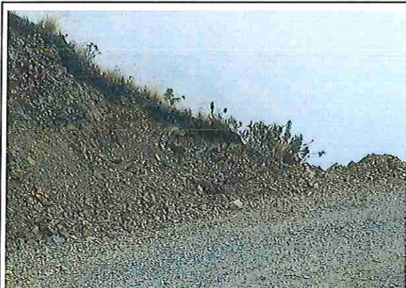
foto 149: KM 07 + 400 Terreno plano con un ancho de superficie de 4.08 m.
