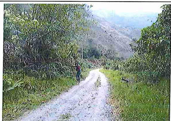
foto 355: KM 17 + 700 Terreno plano con un ancho de superficie de 4.08 m.
