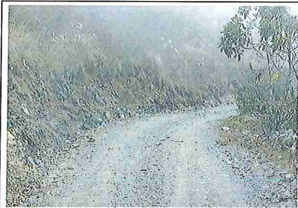
foto 169: KM 08 + 400 Terreno plano con un ancho de superficie 4.04 m.
