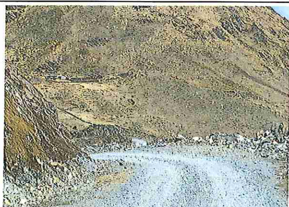
foto 29: KM 01 + 400 Terreno plano con un ancho de superficie 3.99 m.
