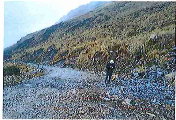
foto 50: KM 02 + 450 Terreno ondulado con un ancho de superficie 3.88 m.
