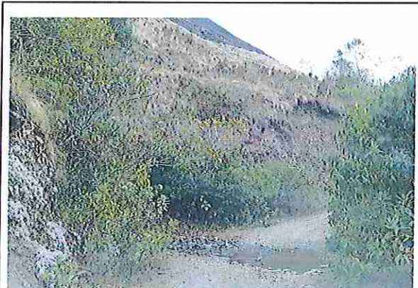
foto 14: KM 00 + 650 Terreno ondulado con un ancho de superficie 4.03 m.
