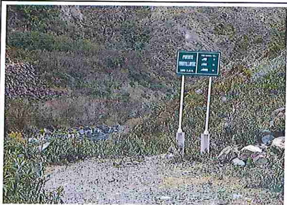
FOTO N°03: SEÑAL INFORMATIVA 06 + 700, estado regular. Falta pintura.
