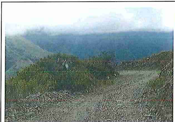
foto 277: KM 13 + 800 Terreno plano con un ancho de superficie de 4.02 m.
