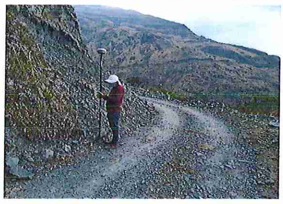
foto 298: KM 14 + 850 Terreno ondulado con un ancho de superficie de 3.97 m.
