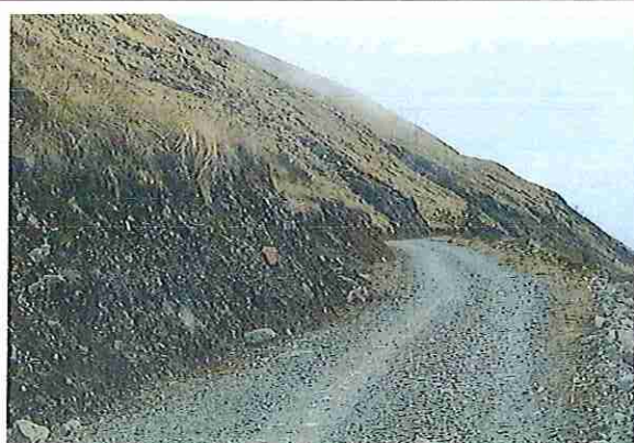
foto 89: KM 04 + 400 Terreno ondulado con un ancho de superficie 4.04 m.
