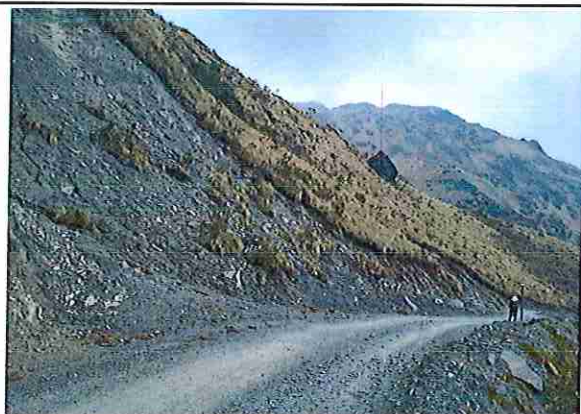
foto 27: KM 01 + 300 Terreno plano con un ancho de superficie 3.89 m.
