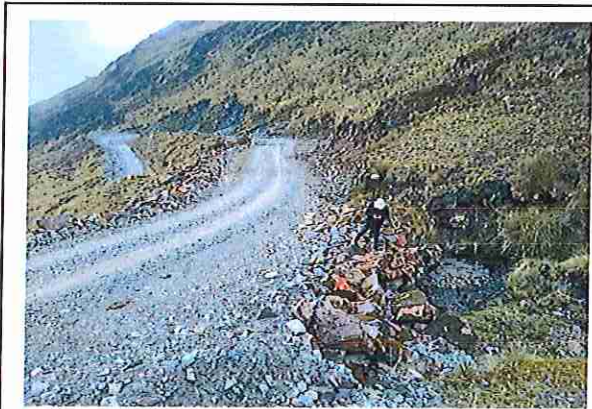
foto 43: KM 02 + 100 Terreno plano con un ancho de superficie de 4.08 m.
