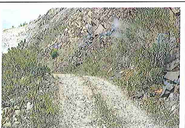
foto 77: KM 03 + 800 Terreno plano con un ancho de superficie 3.99 m.
