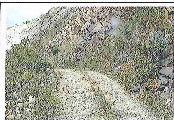
foto 63: KM 03 + 100 Terreno plano con un ancho de superficie 3.98 m.
