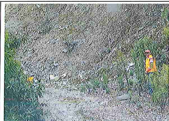
foto 85: KM 04 + 200 Terreno ondulado con un ancho de superficie 4.00 m.
