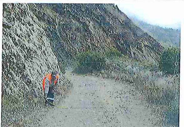
foto 05: KM 00 + 200 Terreno ondulado con un ancho de superficie 3.84 m.
