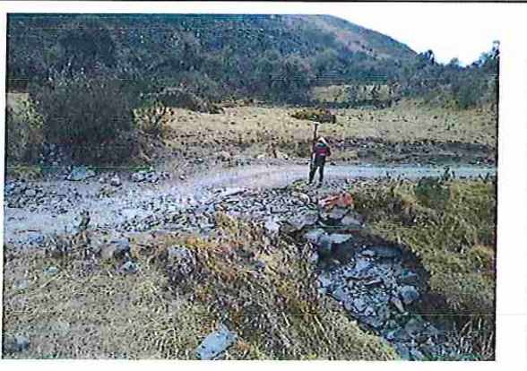
foto 118: KM 05 + 850 Terreno accidentado con un ancho de superficie 3.56 m.
