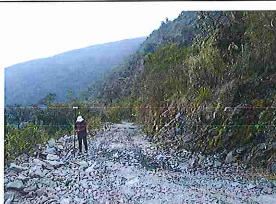
foto 266: KM 13 + 250 Terreno accidentado con un ancho de superficie de 3.99 m.
