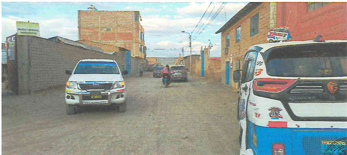
Imagen N° 05: En la imagen se muestra la Av. Ayacucho quinta cuadra. Sin concreto ni asfalto
