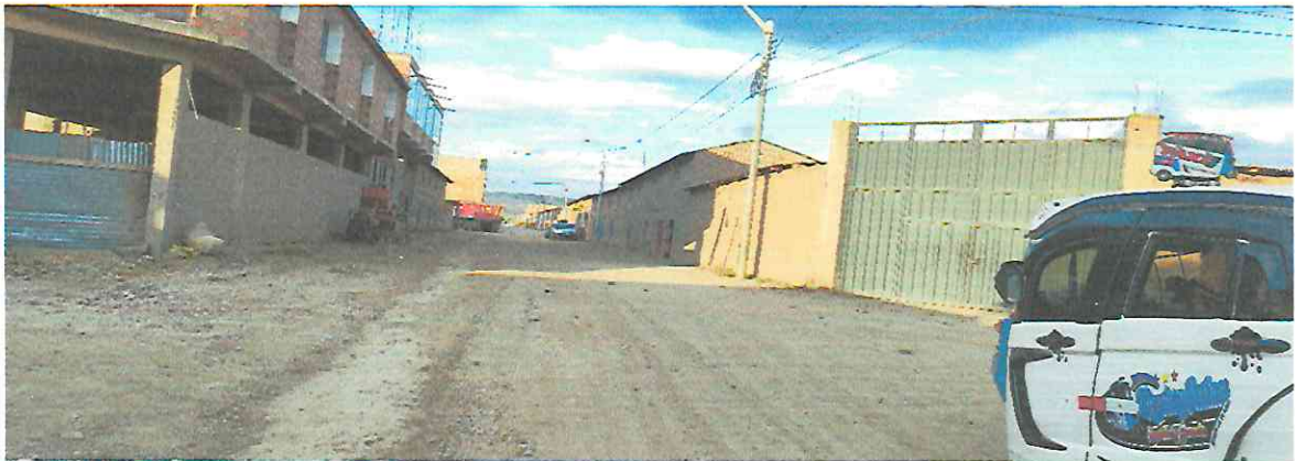
Imagen N° 04: En la imagen se muestra la Av. Ayacucho cuarta cuadra. Sin concreto ni asfalto
